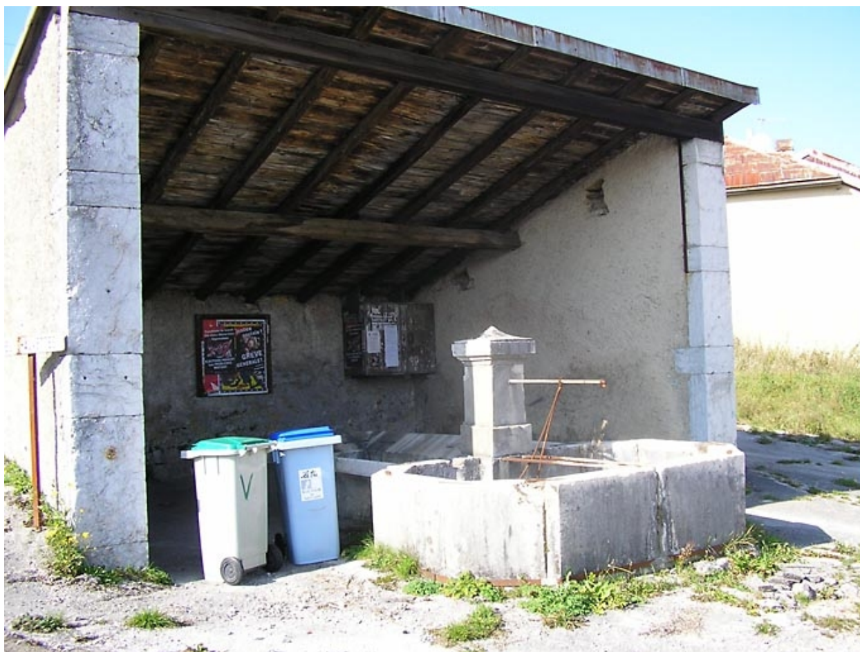
Fontaine-lavoir située au lieu-dit Le Pont de Lemme.
