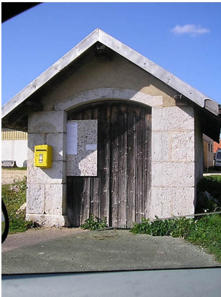
Remise de matériel incendie située au lieu-dit Les Chauvettes du Vent.
