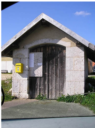
Remise de matériel incendie située au lieu-dit Les Chauvettes du Vent. Phot. Marie-Pierre Reynet IVR43_20083900100NUC1A
