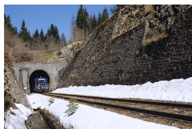
Tunnel dit souterrain du Saut (voie ferrée Andelot - La Cluse). Phot. Yves Sancey IVR43_20053900237ZA
