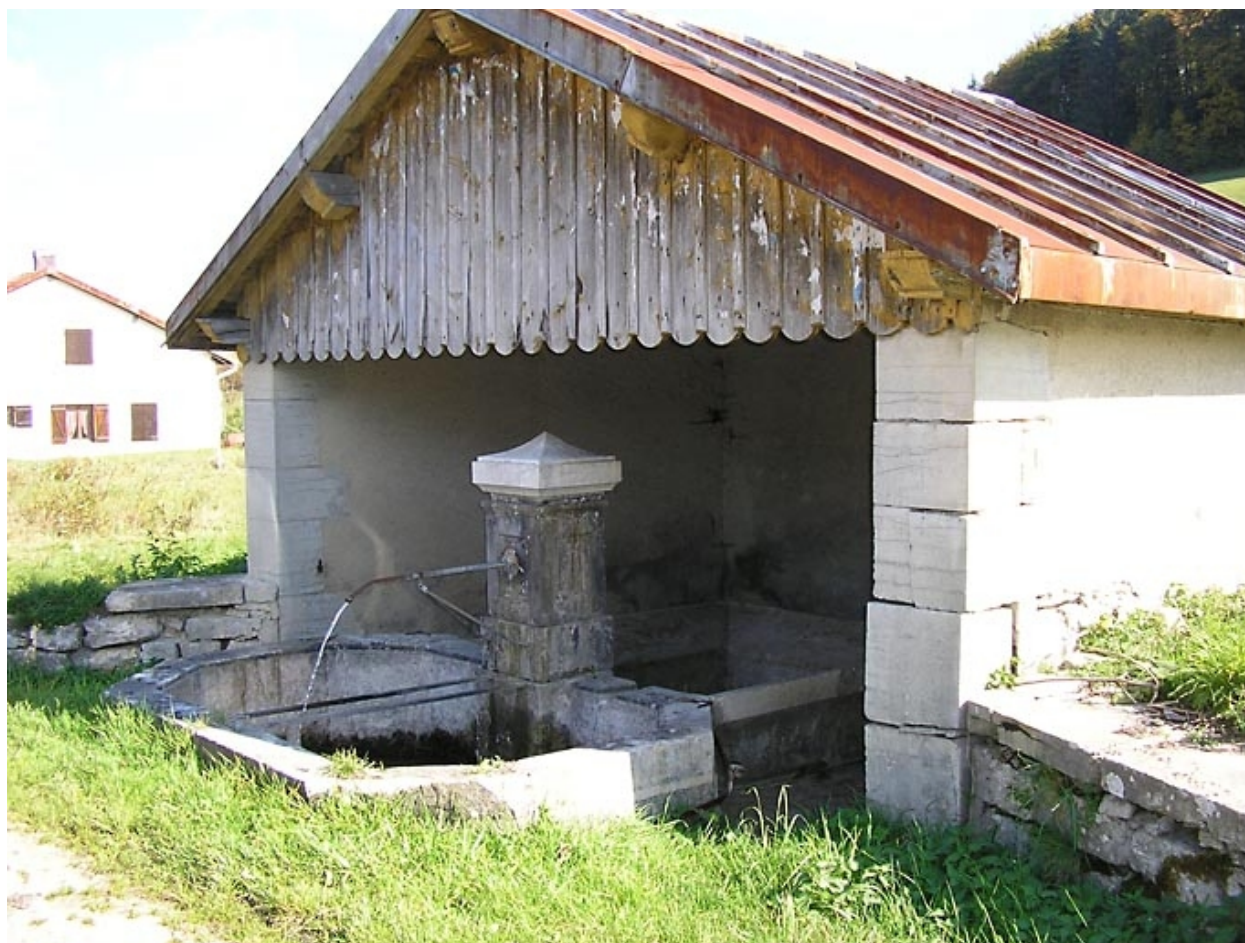
Fontaine-lavoir-abreuvoir situé au lieu-dit Pont de Lemme.
