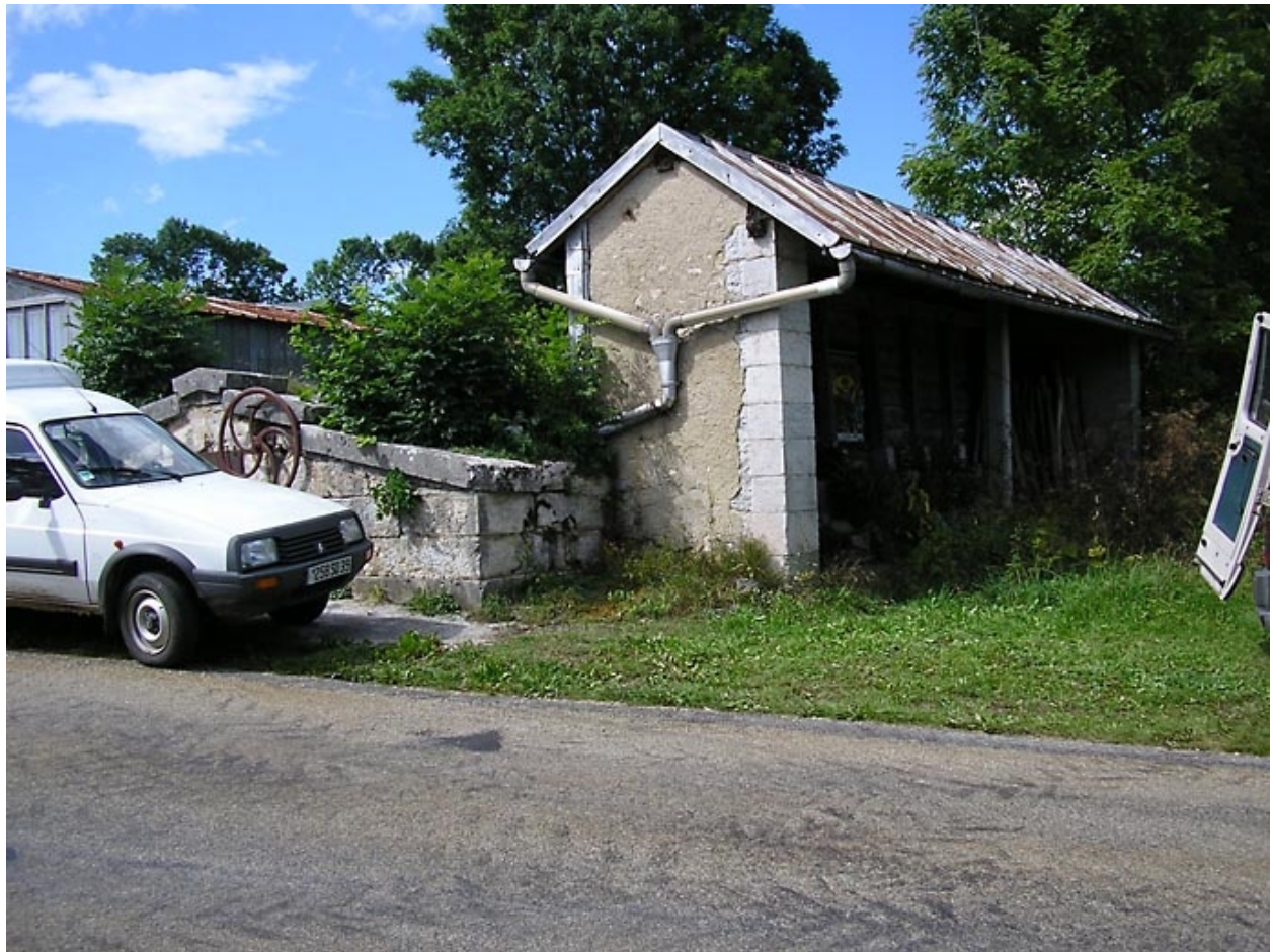
Fontaine siuée route de Saint-Pierre.
