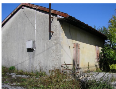
Halte de voyageurs située 7 route de Genève. Phot. Marie-Pierre Reynet IVR43_20083900090NUC1A
