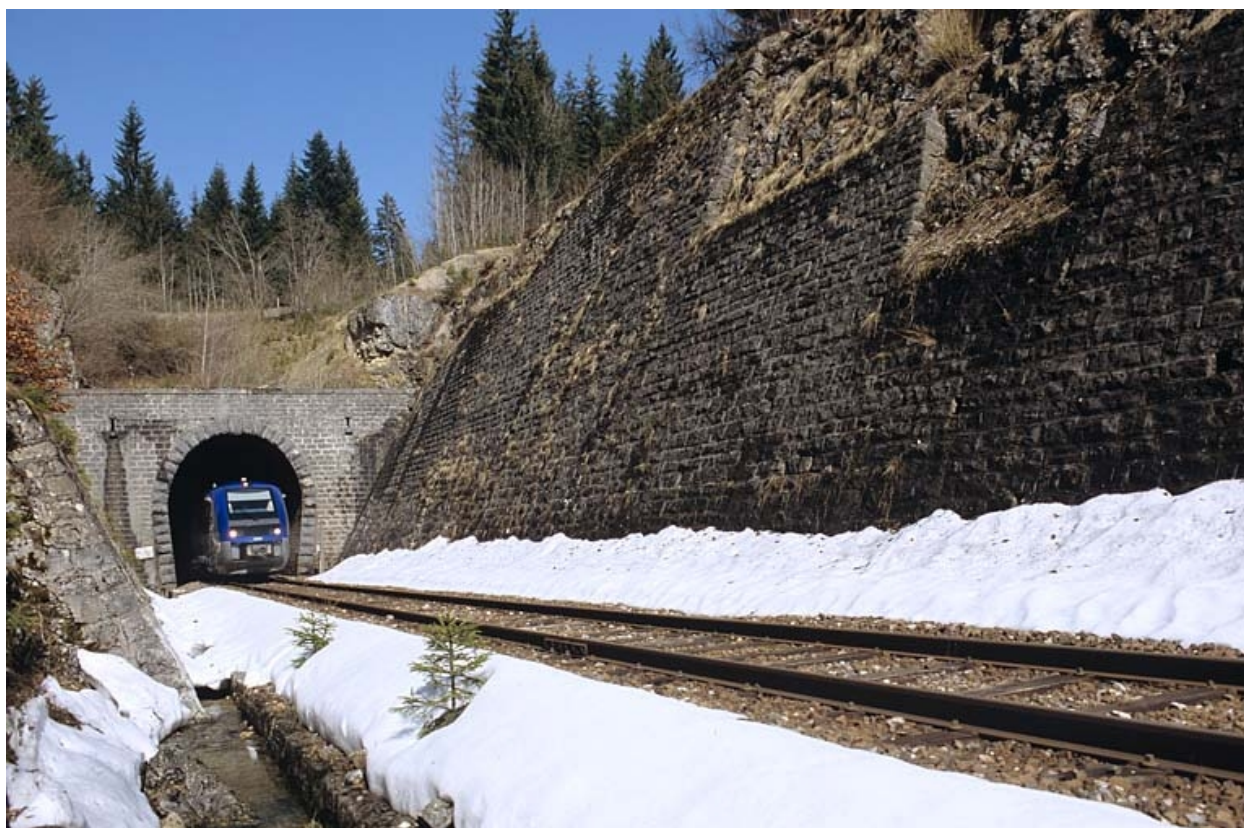
Tunnel dit souterrain du Saut (voie ferrée Andelot - La Cluse).
