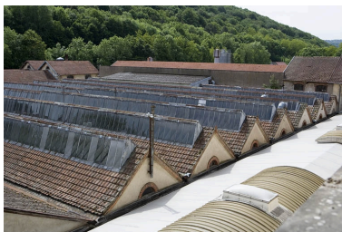
Atelier de fabrication. Vue des toitures.
