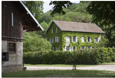
Maison de direction. Façade antérieure. Phot. Yves Sancey
