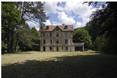
Logement patronal. Façade postérieure. Phot. Yves Sancey
