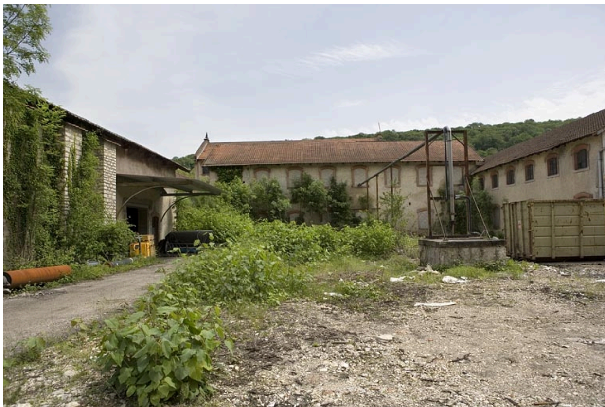
Entrepôt industriel (?). Façade ouest.
