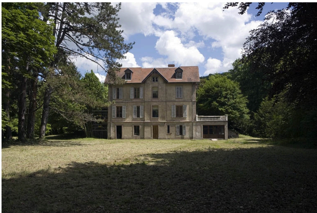
Logement patronal. Façade postérieure.
