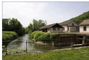
Bief de dérivation et hangar industriel.
