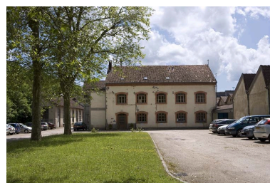
Bureaux. Façade antérieure. Phot. Yves Sancey IVR43_20092500611NUC2A
