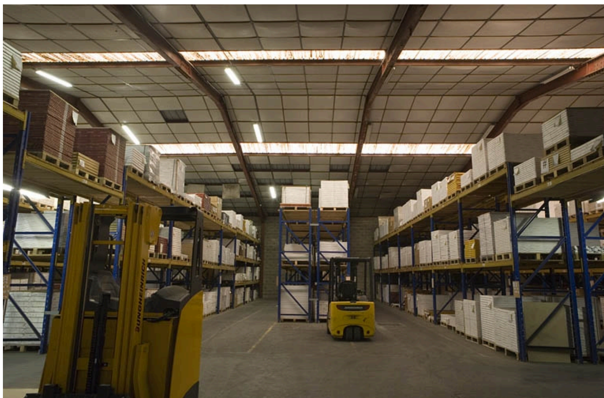
Magasin industriel (récent). Vue intérieure.
