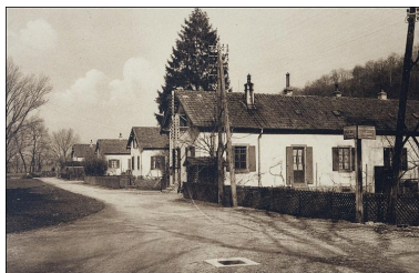
Cité ouvrière, rue de la Poste. Phot. Yves Sancey IVR43_20092500705NUC2A
