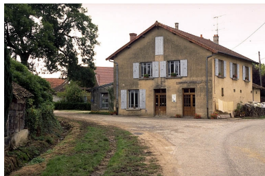
Vue d'ensemble. Phot. Jérôme Mongreville IVR43_19953900444ZA
