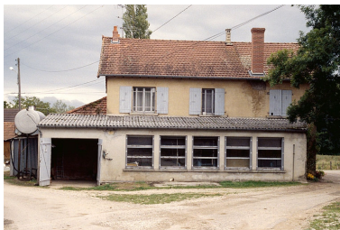
Façade latérale depuis le nord. Phot. Jérôme Mongreville IVR43_19953900446ZA
