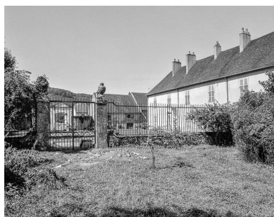
La grille au fond de la cour. Phot. Yves Sancey IVR43_19843900044X
