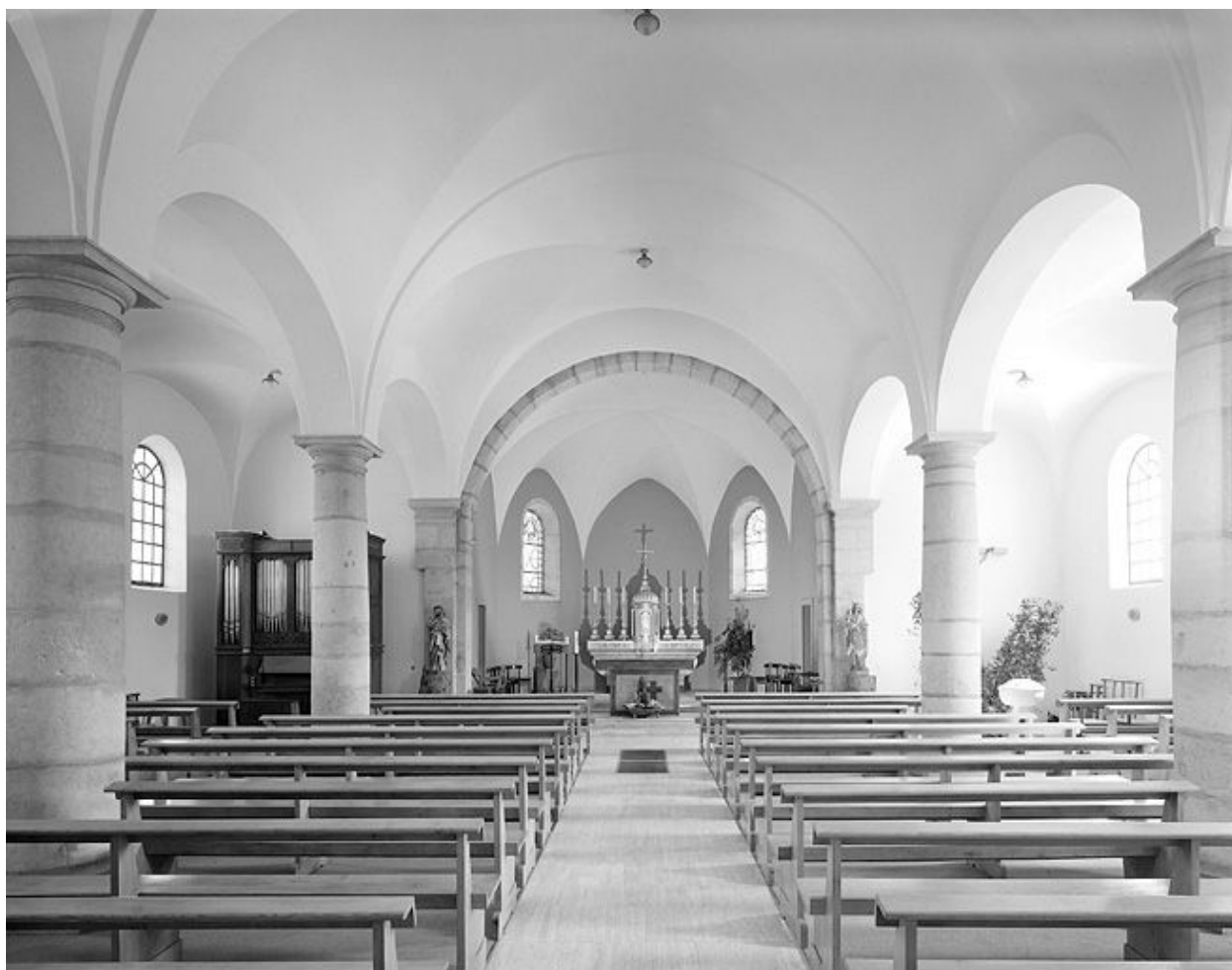
Le vaisseau central vu depuis l'entrée.
