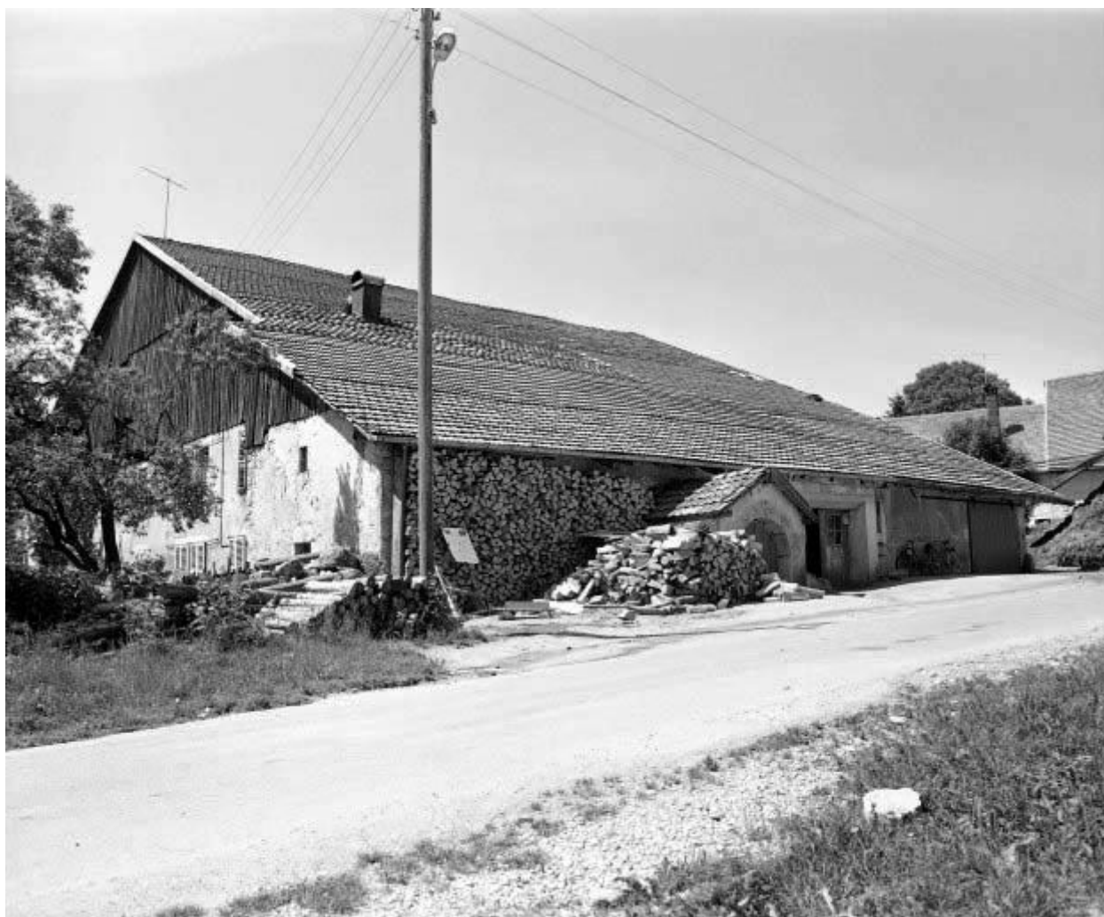
Facades antérieure et latérale droite.
