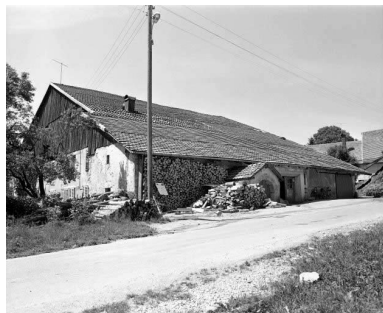
Facades antérieure et latérale droite.
