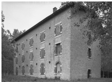
Elévations postérieure et droite. Phot. Michel Rosso IVR26_19882102772V
