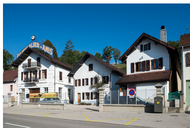
Vue d'ensemble depuis la rue des Lavaux. Phot. Jérôme Mongreville IVR43_2016250115NUC4A
