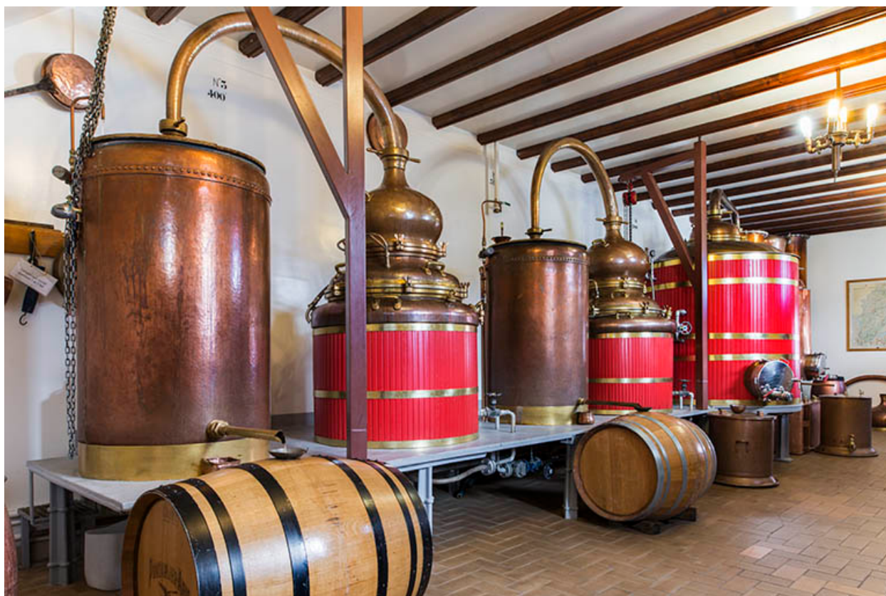
Salle de distillation. Vue d'ensemble.
