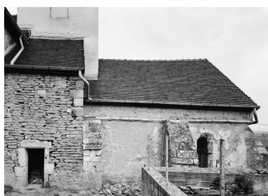
Elévation droite du choir. Phot. Michel Rosso IVR26_19792100131V
