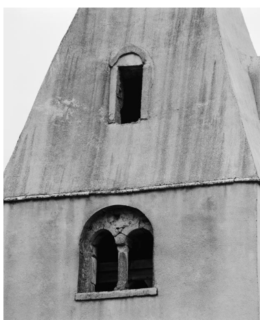
Détail des baies antérieures du clocher. Phot. Michel Thierry IVR26_19792100142X
