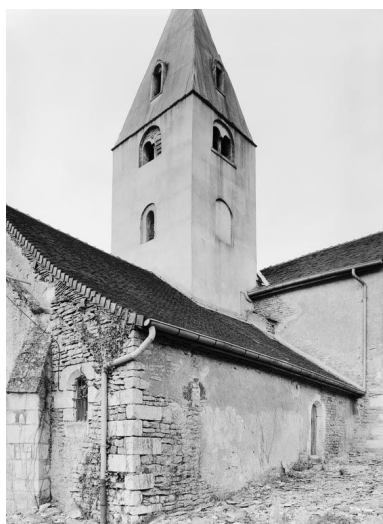
Elévation gauche du choeur et clocher. Phot. Michel Rosso IVR26_19792100129V
