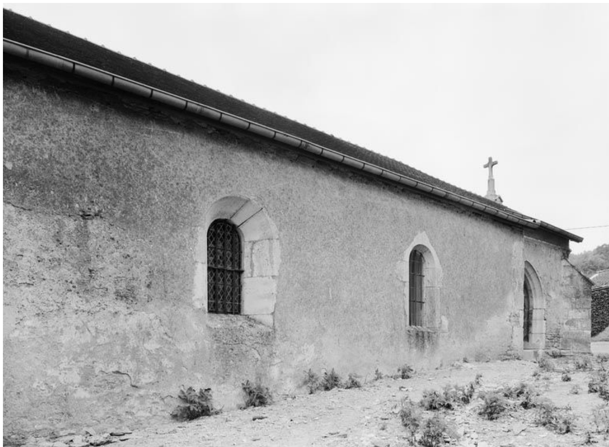
Elévation gauche de la nef.
