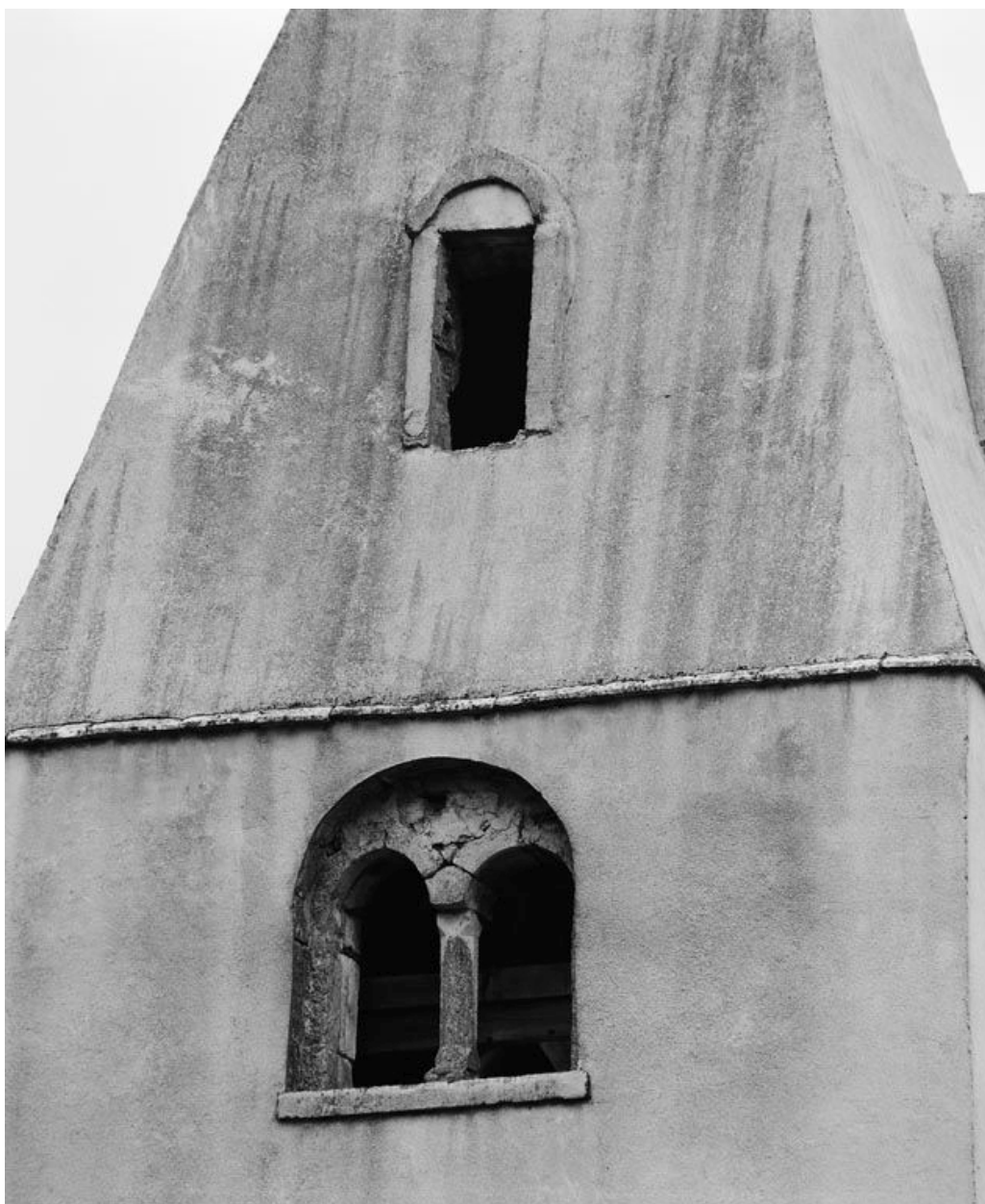
Détail des baies antérieures du clocher.
