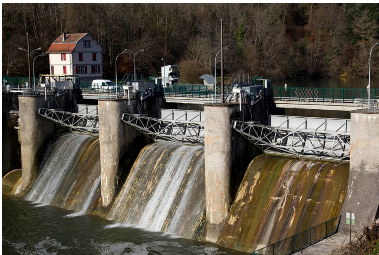
Barrage depuis la rive gauche en aval.
