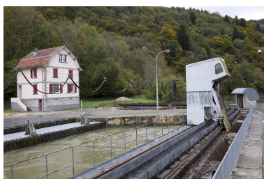
Prise d'eau : vue d'ensemble du dégrilleur. Phot. Yves Sancey IVR43_20122501980NUC2A
