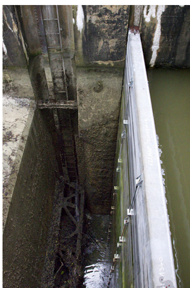
Barrage : batardeau protégeant la vanne clapet en réparation. Phot. Yves Sancey IVR43_20122501984NUC2A
