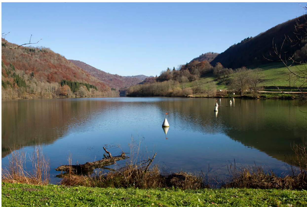
Bassin de retenue depuis la rive droite.
