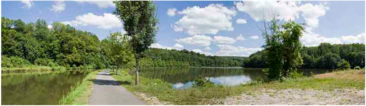
Vue en amont de l'écluse.
