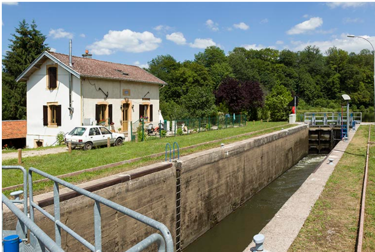
Le site d'écluse, depuis l'aval.
