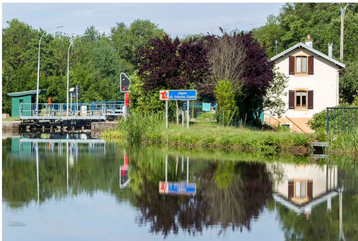
Vue d'ensemble depuis l'amont.
