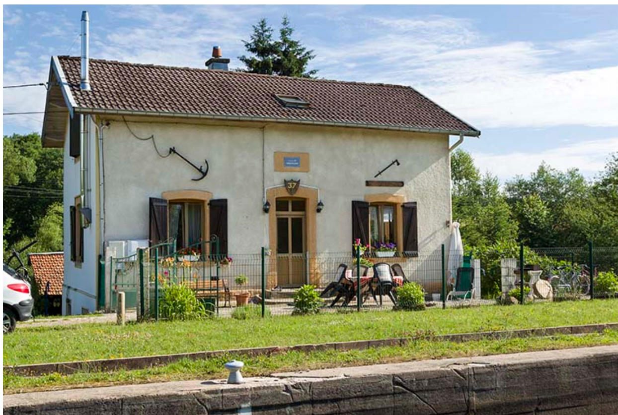
La maison d'éclusier, depuis l'écluse.
