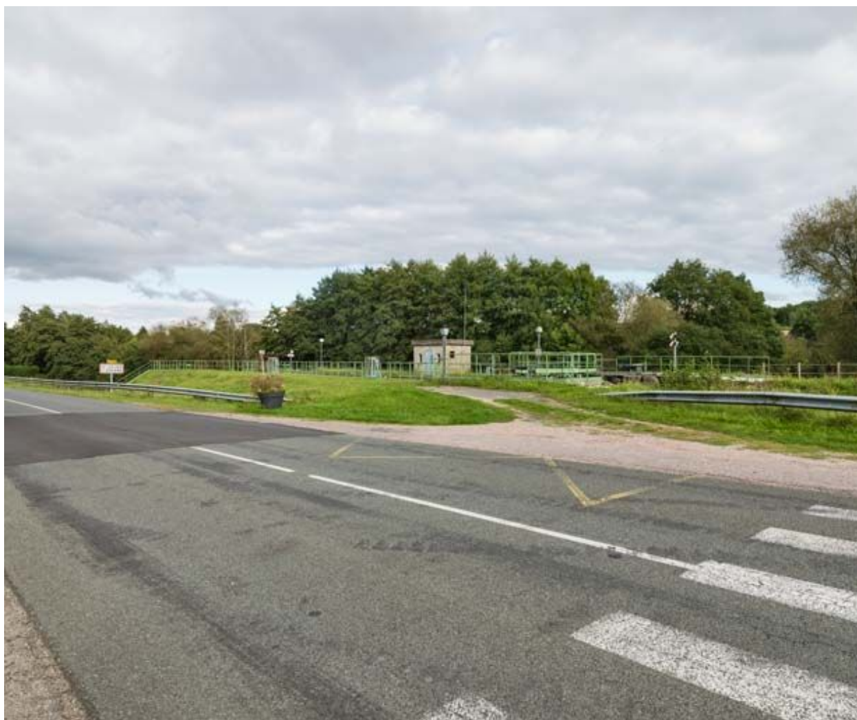
Vue d'ensemble du site d'écluse.
