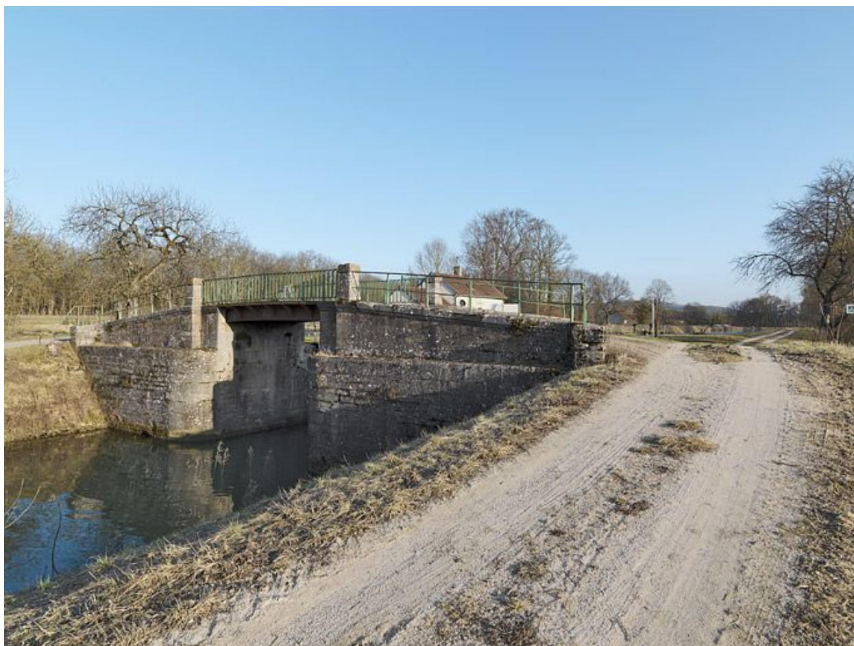
Le pont sur écluse vu d'aval.
