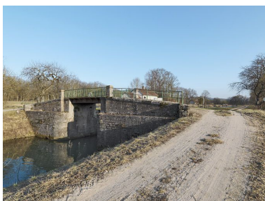
Le pont sur écluse vu d'aval.
