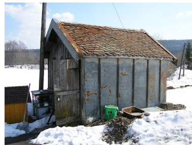
L'atelier vu de trois quarts. Phot. Marie-Pierre Reynet IVR43_20083900256NUC1A
