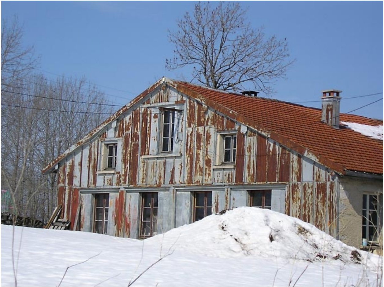
Vue du pignon sud-ouest.
