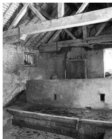
Lavoir, vue intérieure. Phot. Michel Rosso IVR26_19872100669X
