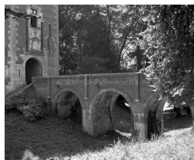
Pont dormant remplaçant l'ancien pont-levis. Phot. Michel Rosso IVR26_19872100663X
