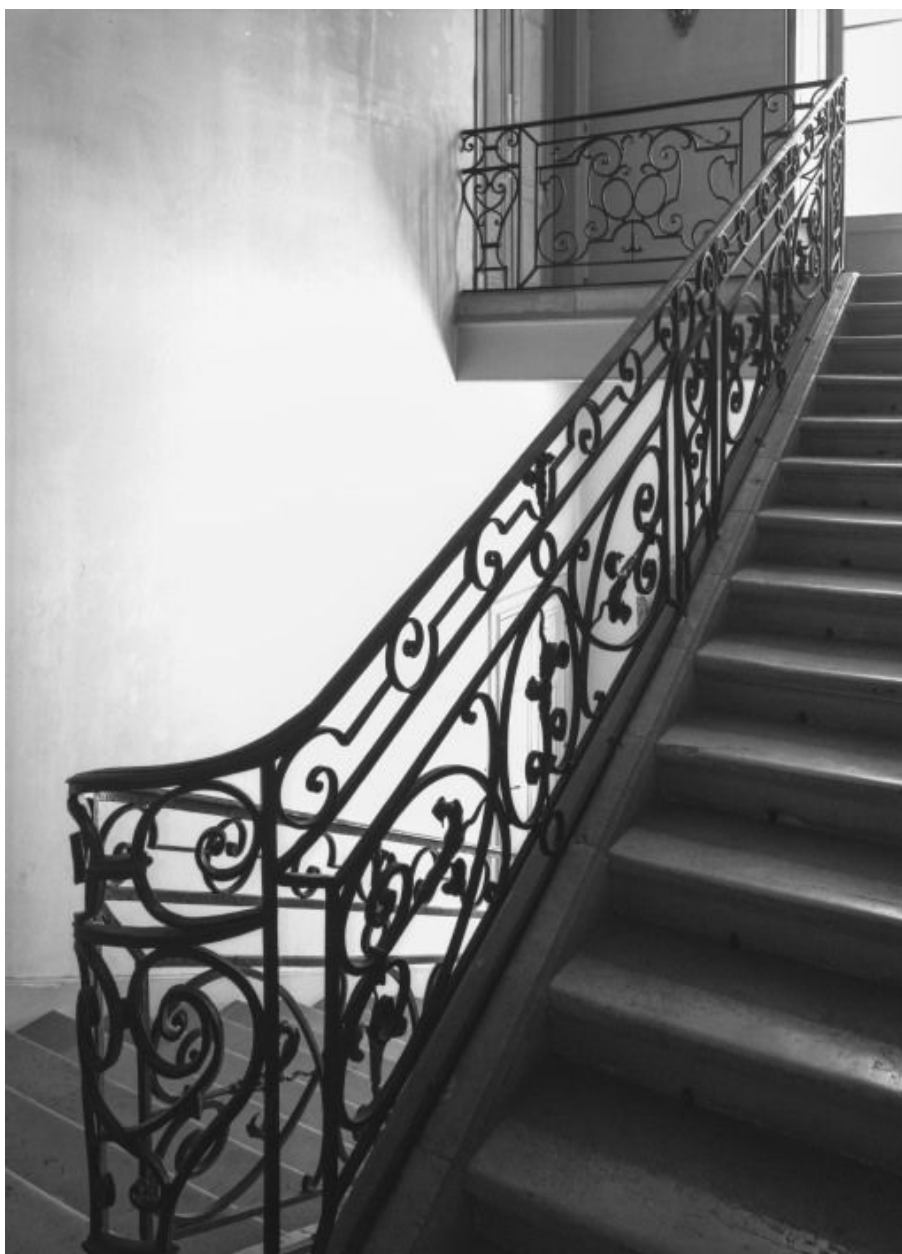
Escalier du corps principal.
