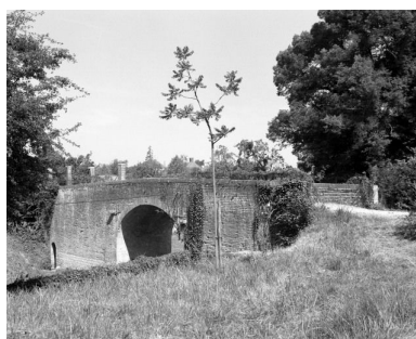
Pont reliant la cour au potager. Phot. Michel Rosso IVR26_19872100664X
