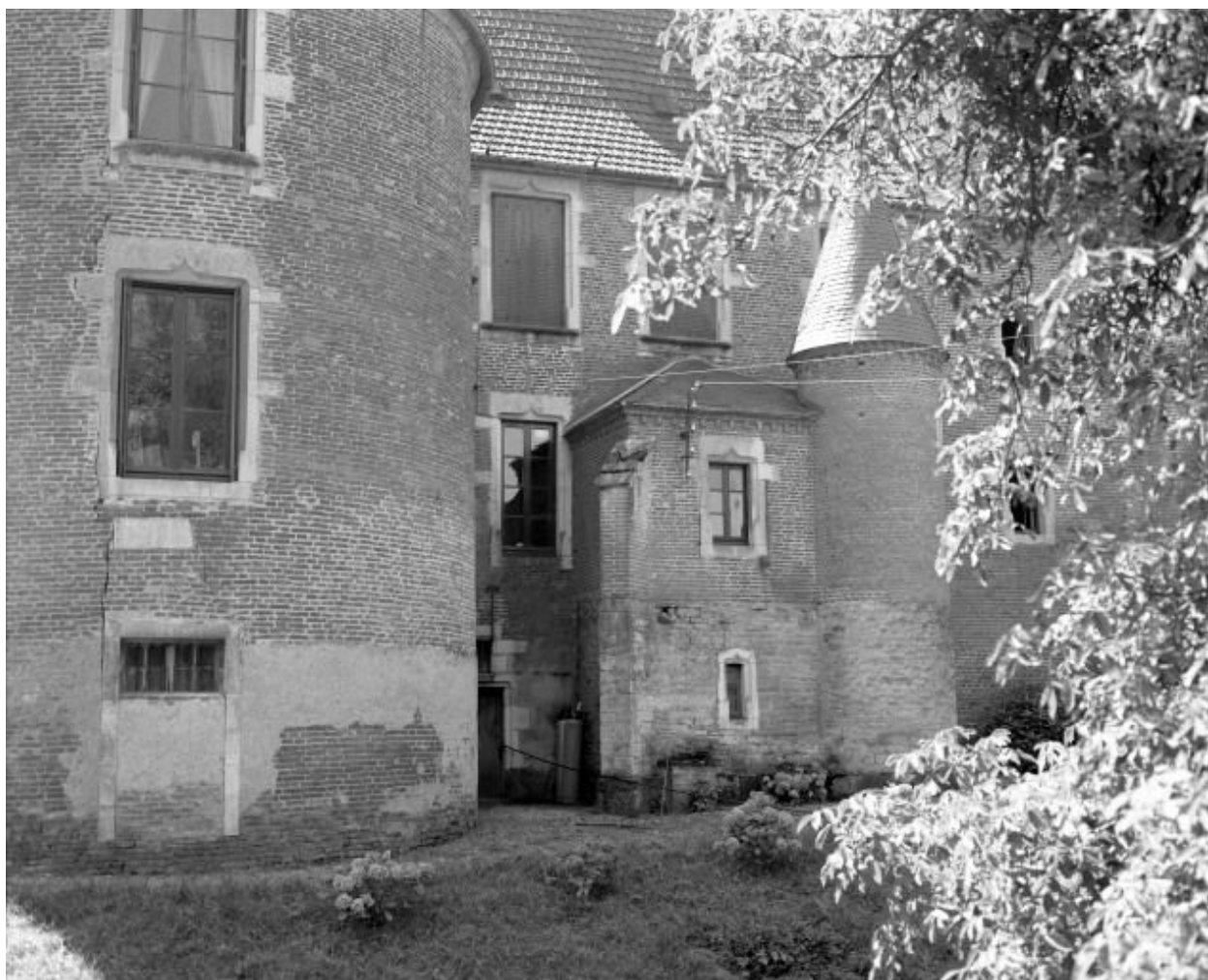
Elévation postérieure, détail.
