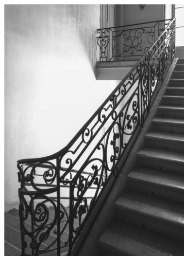
Escalier du corps principal. Phot. Michel Rosso IVR26_19872100662V
