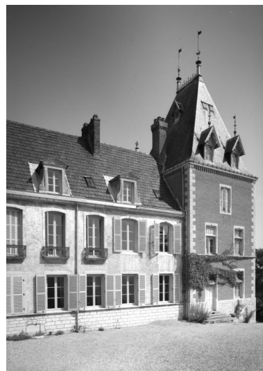
Partie gauche de la façade. Phot. Michel Rosso IVR26_19872100654V
