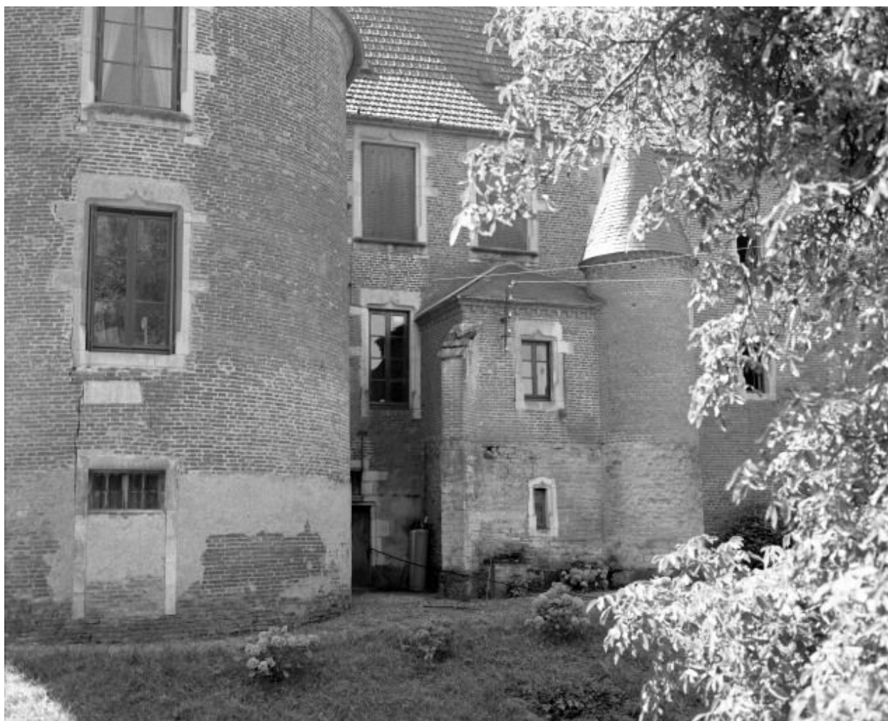
Elévation postérieure, détail.
