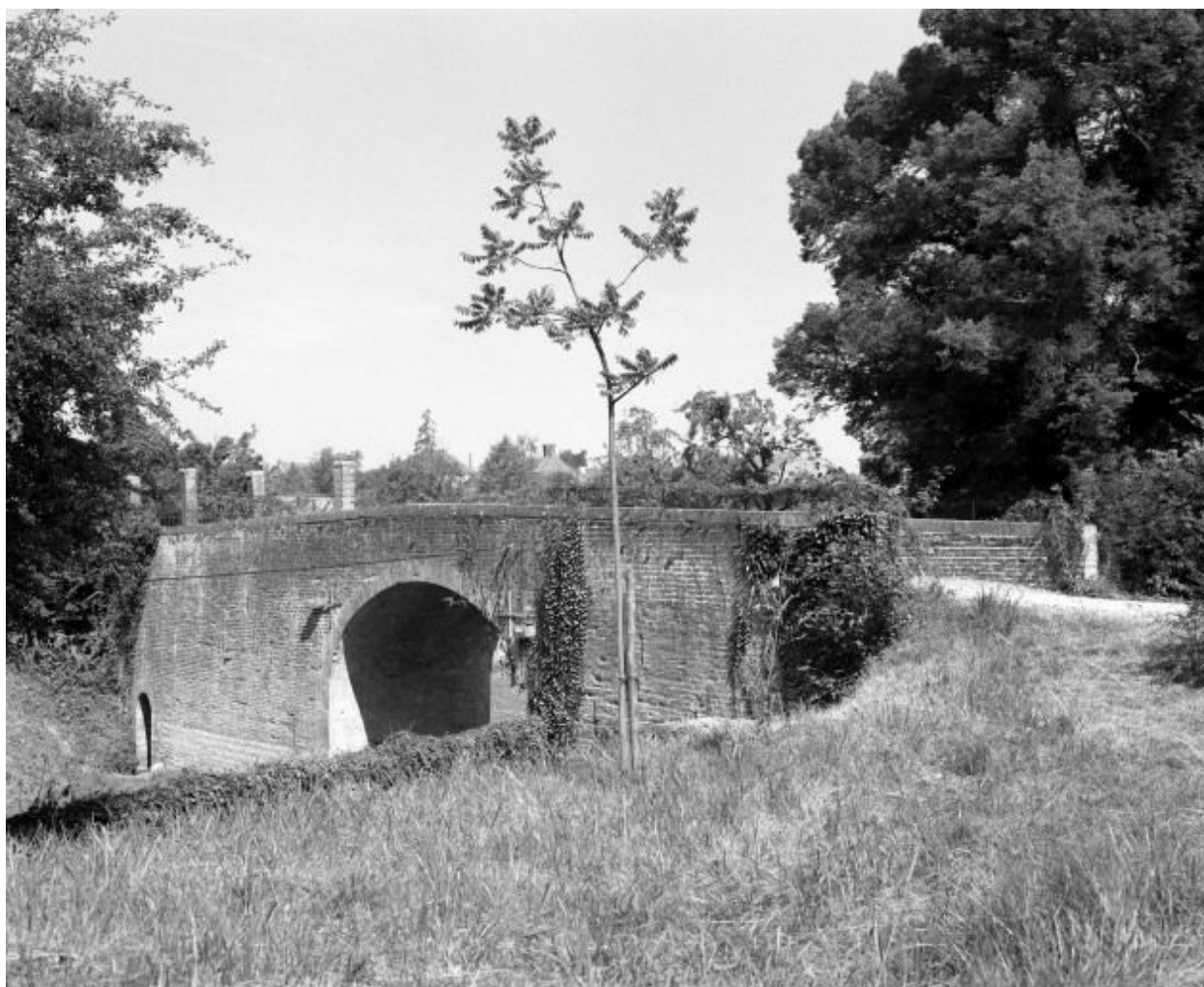
Pont reliant la cour au potager.
