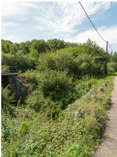
Vue de l'aqueduc. Phot. Pierre-Marie Barbe-Richaud IVR26_20175800362NUC2A
