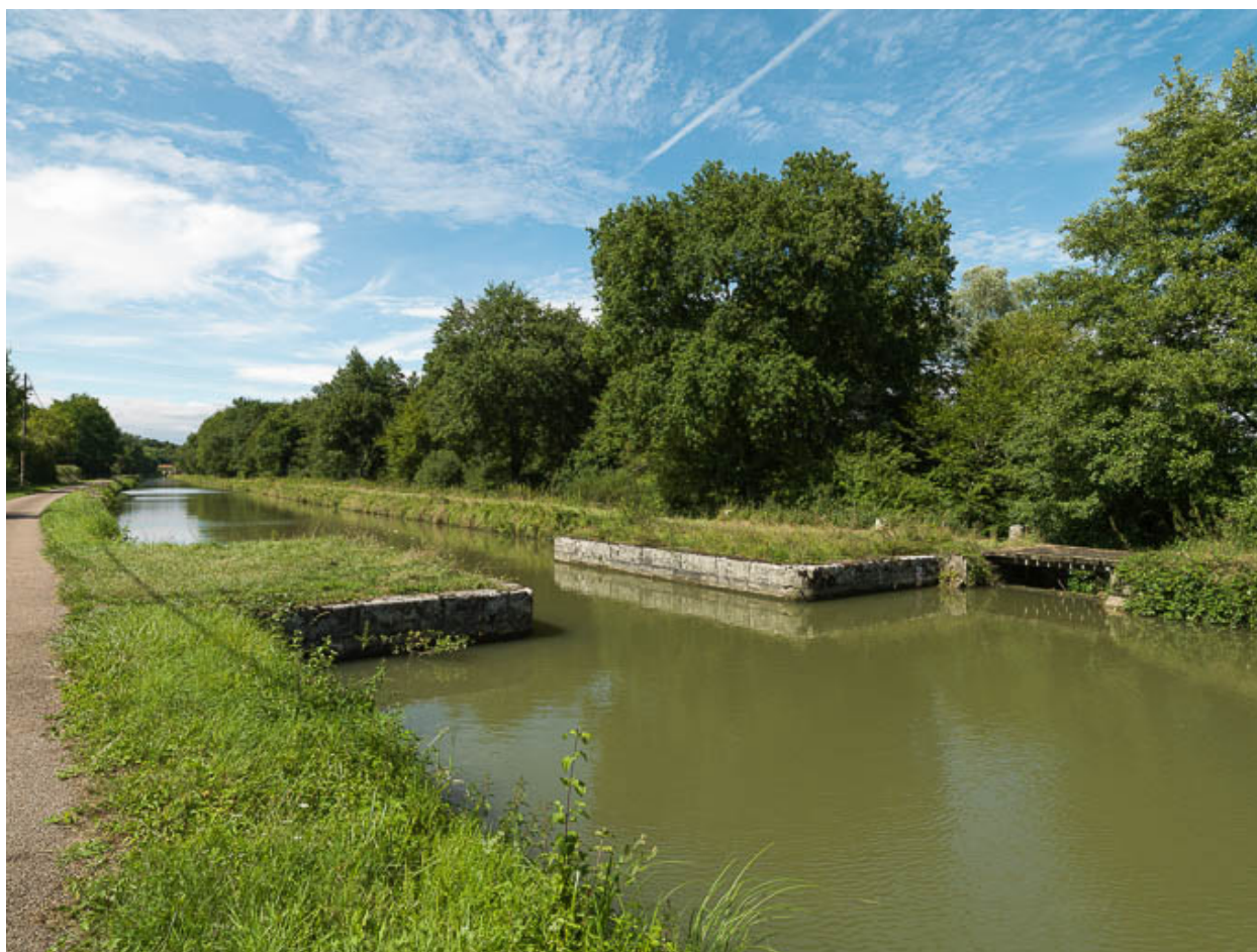
Vue du canal et du déversoir.
