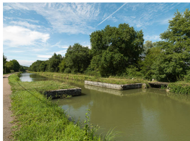
Vue du canal et du déversoir. Phot. Pierre-Marie Barbe-Richaud IVR26_20175800363NUC2A
