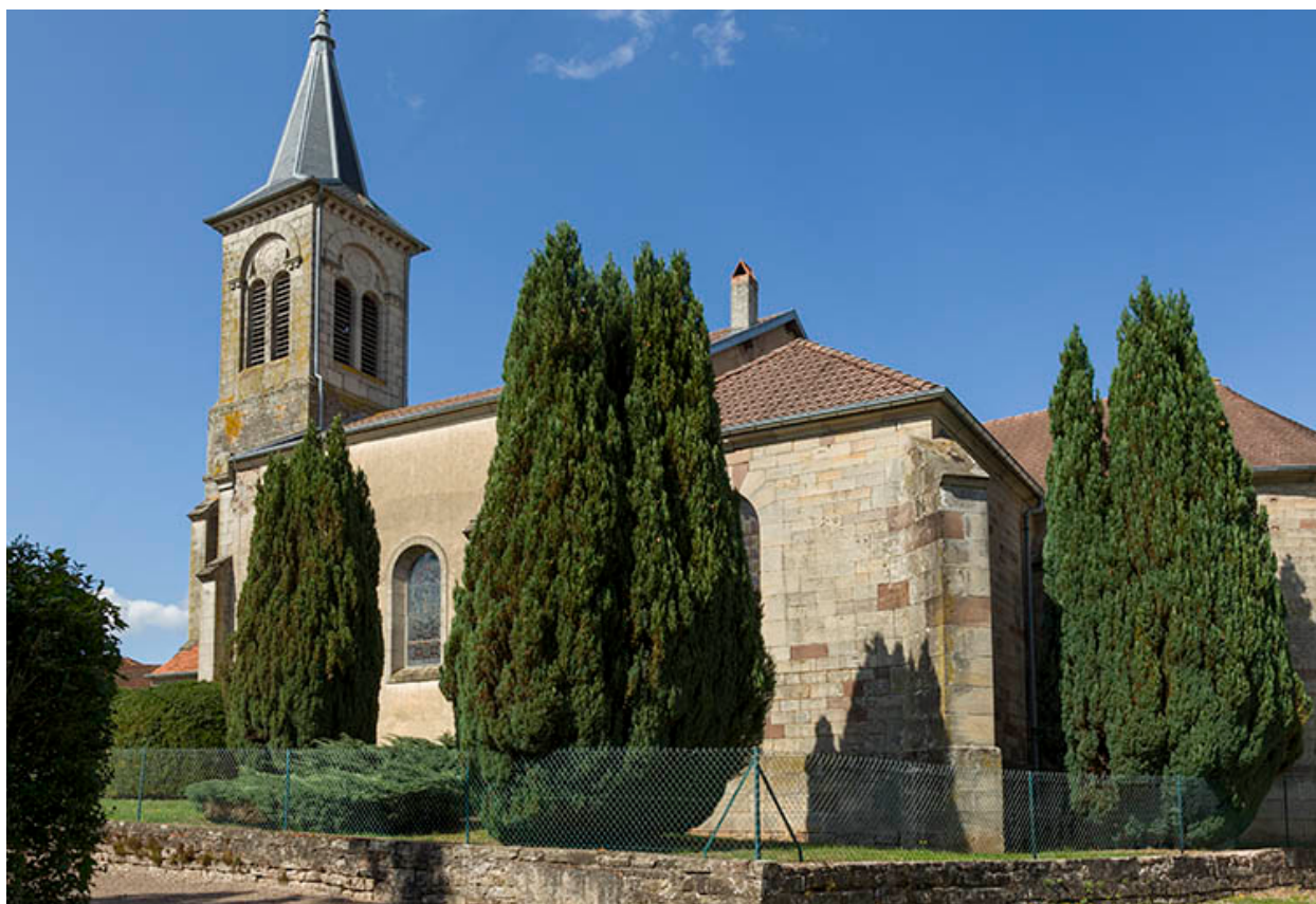
Façade latérale sud de la nef.
