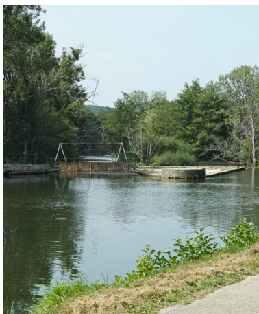
Vue du barrage.
