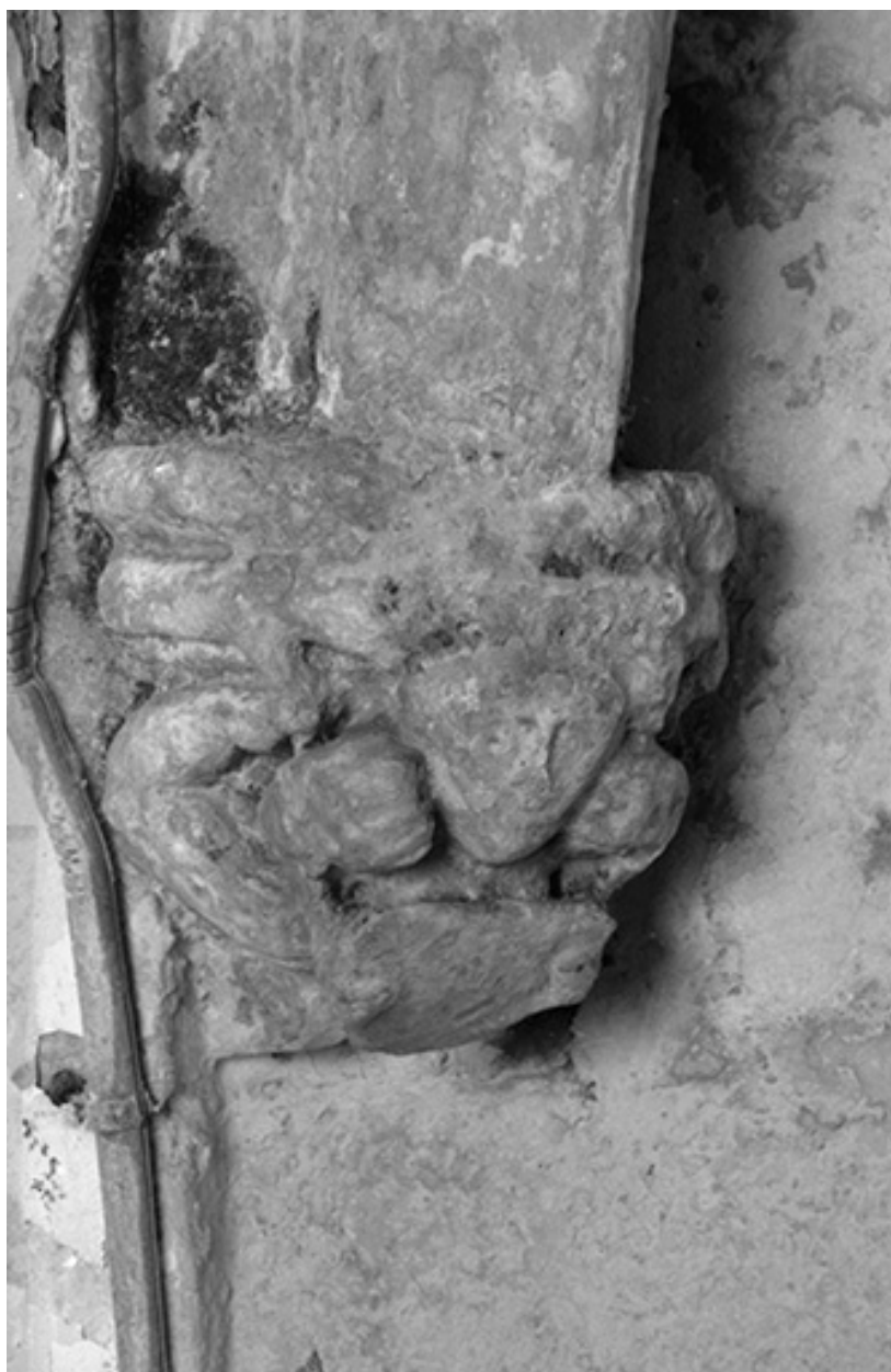
Culot du rez-de-chaussée de la tour-clocher.
