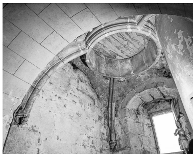
Clef de voûte. Phot. Yves Sancey IVR43_19752500190X
