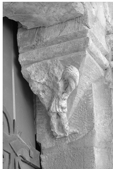
Culot du transept (3). Phot. Yves Sancey IVR43_19752500925Z
