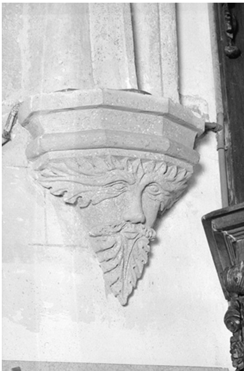
Culot. 1ère travée du chœur. Mur nord.
