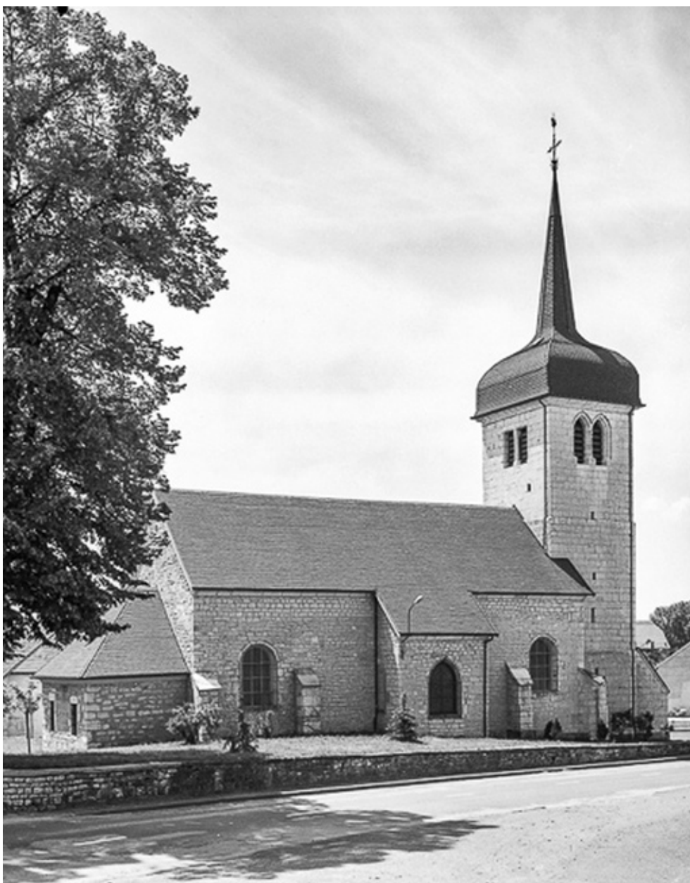
Extérieur : façade latérale gauche.
