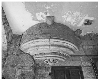
Base de l'escalier de la tour-clocher. Phot. Yves Sancey IVR43_19752500189X
