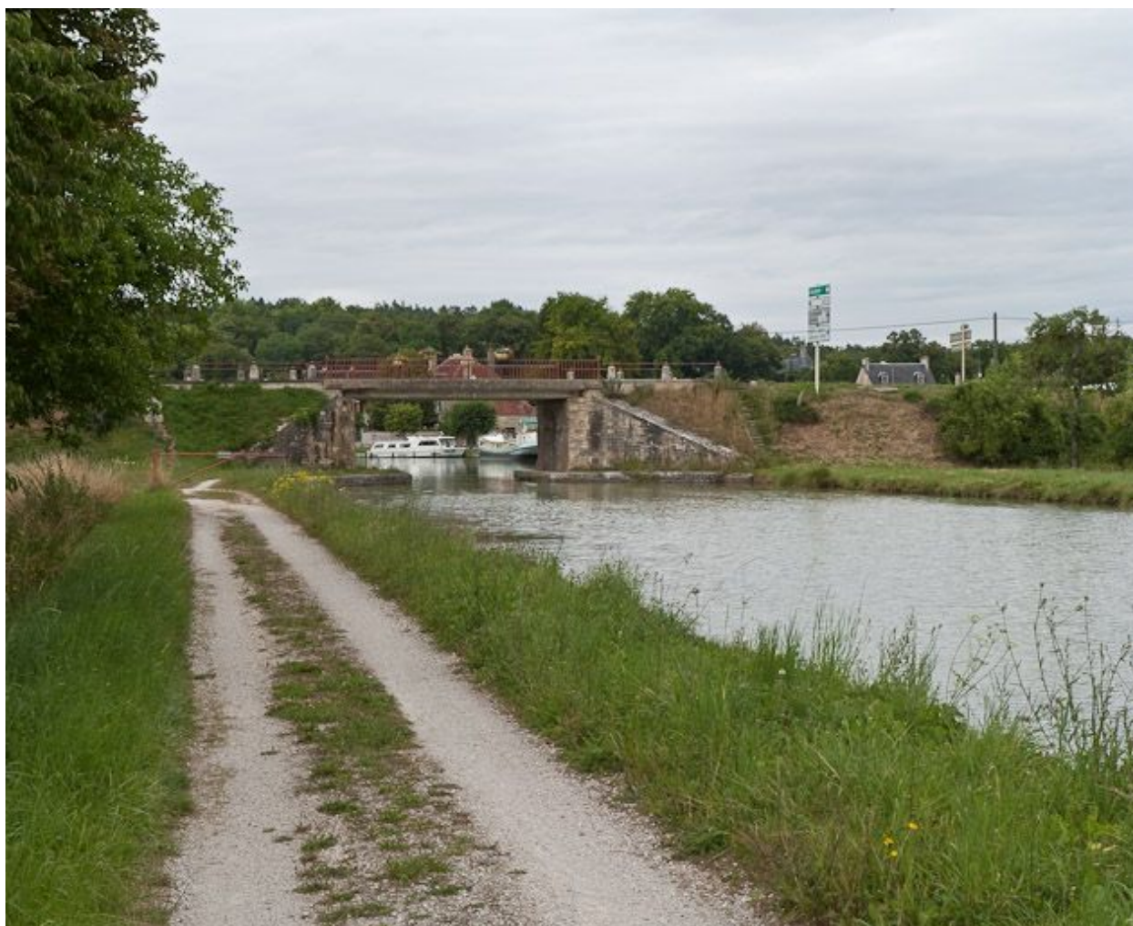
Vue du pont depuis l'amont.
