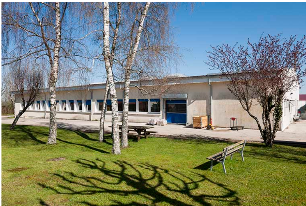
Vue depuis le sud-est.
