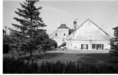
Façade latérale droite. Phot. Bernard Lardière IVR43_19797000140Z
