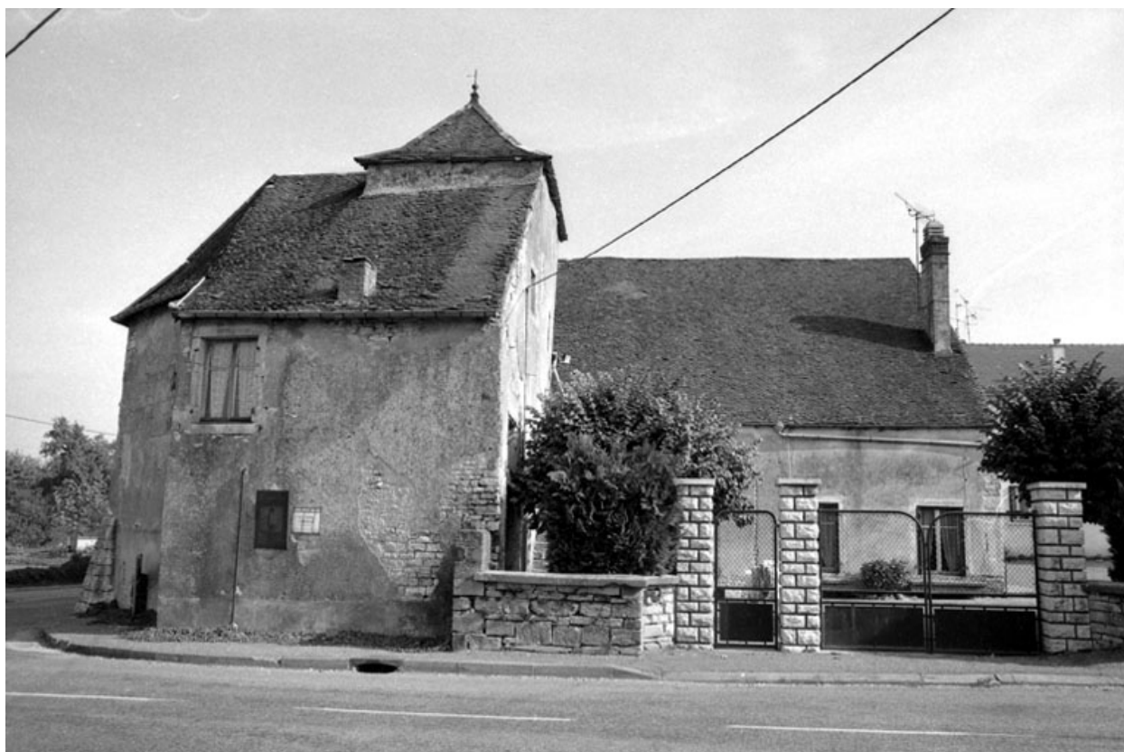
Façades sur cour.
