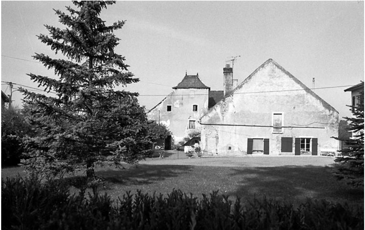
Façade latérale droite.
