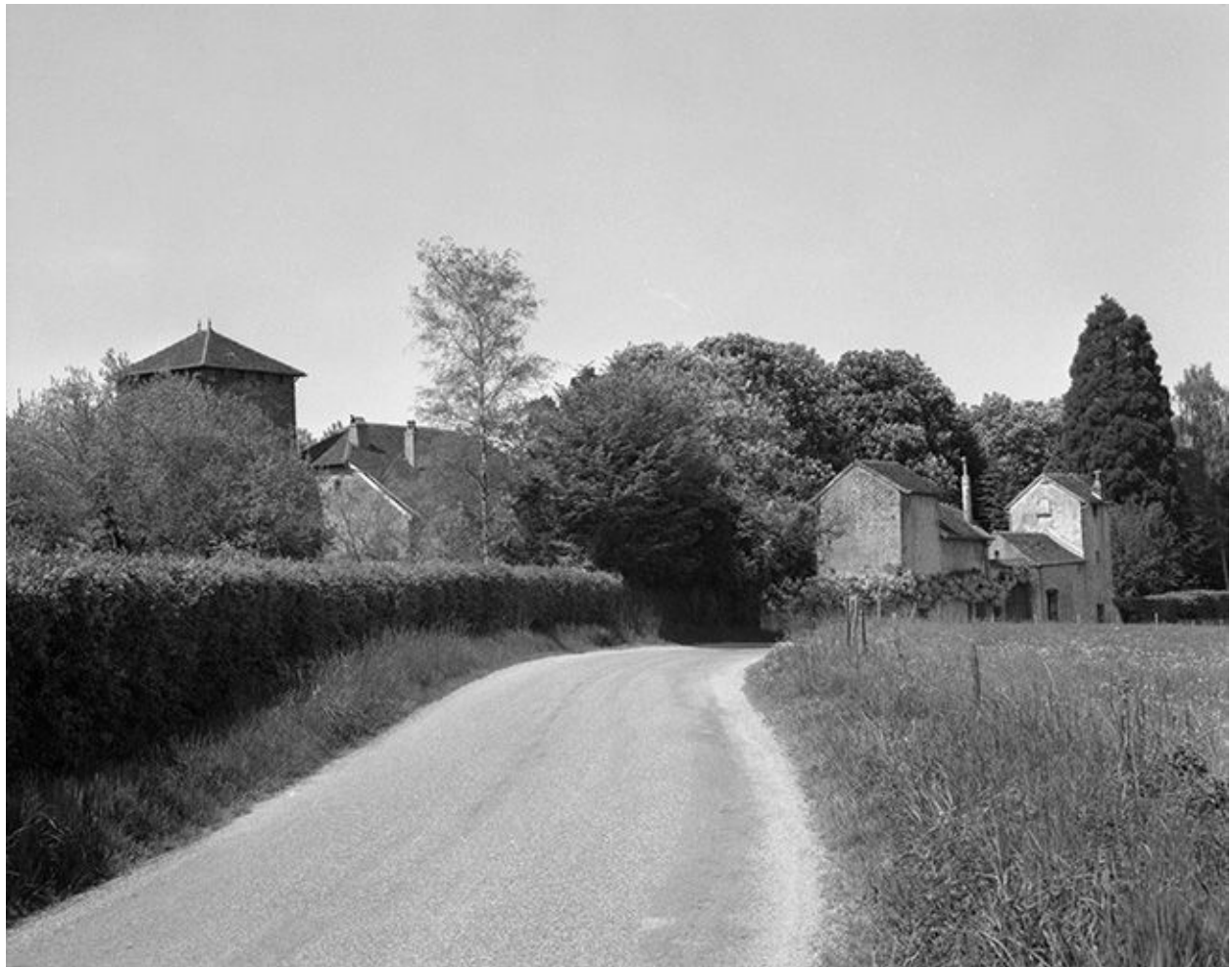
Vue générale depuis le Sud.
