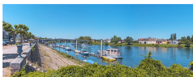
Vue d'ensemble des quais à gradins. Phot. Thierry Kuntz IVR26_20217100460NUC4A
