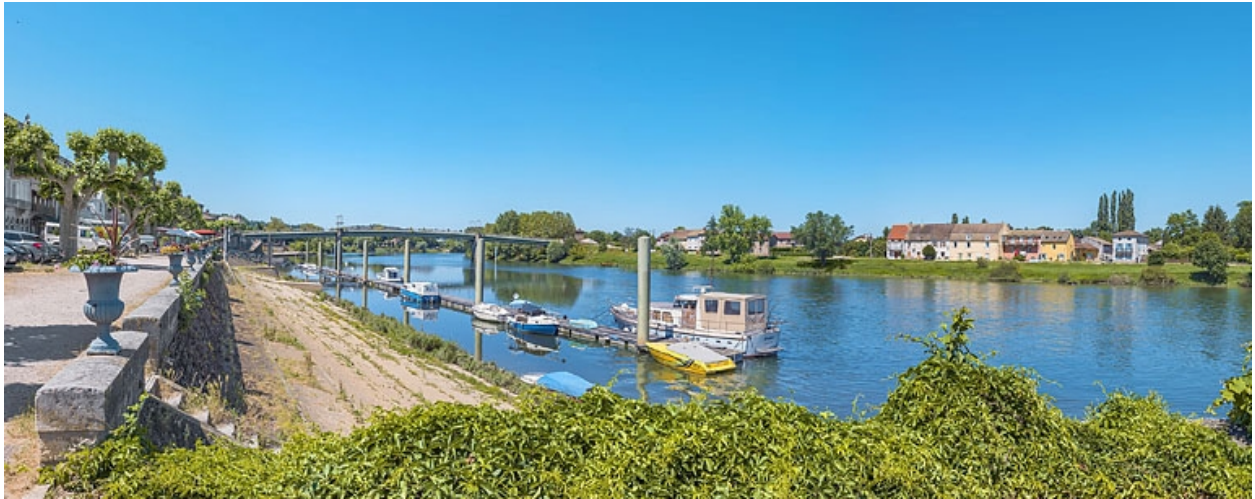
Vue d'ensemble des quais à gradins.
