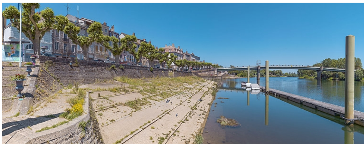
La partie amont des quais à gradins.
