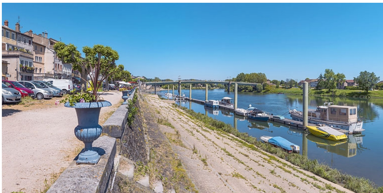
Vue d'ensemble des quais à gradins.
