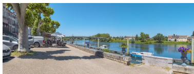
Quai de Verdun, au-dessus des gradins. Phot. Thierry Kuntz IVR26_20217100463NUC4A
