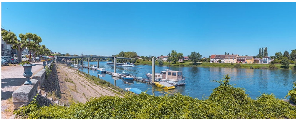
Vue d'ensemble des quais à gradins.
