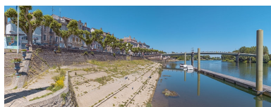
La partie amont des quais à gradins. Phot. Thierry Kuntz IVR26_20217100459NUC4A
