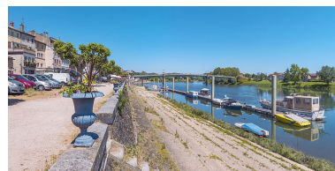
Vue d'ensemble des quais à gradins. Phot. Thierry Kuntz IVR26_20217100458NUC4A
