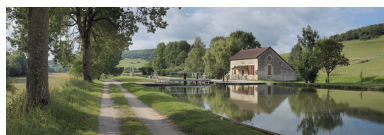
Site d'écluse vu d'amont. Phot. Thierry Kuntz IVR26_20122102229NUC4A
