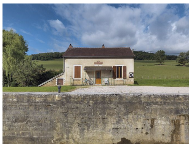
Maison éclusière de face. Phot. Thierry Kuntz IVR26_20122102231NUC4A
