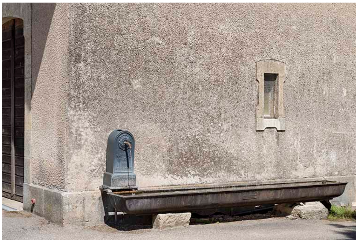
Abreuvoir situé contre la façade droite.
