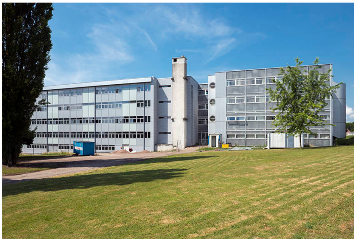
Façades orientales des externats.
