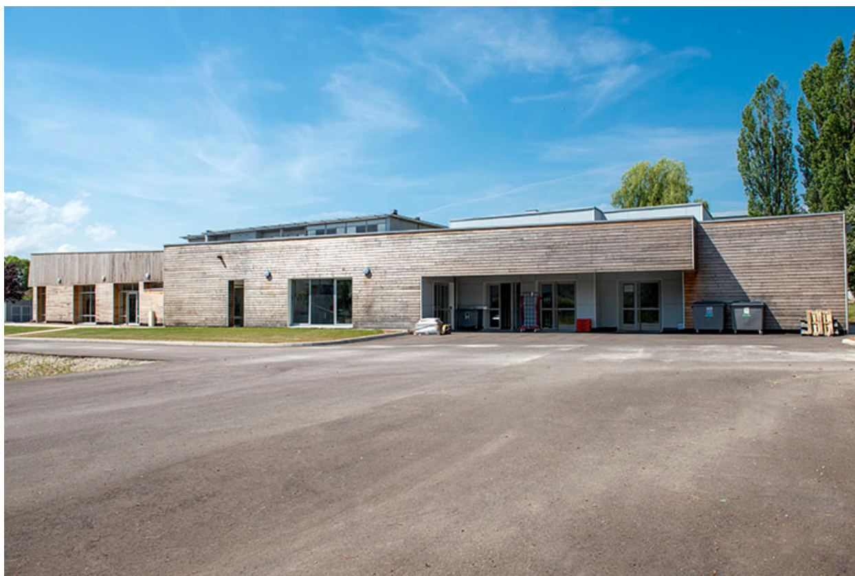
Façade nord-est de la cantine.
