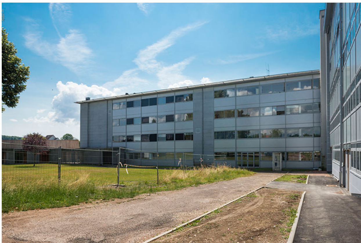
Façade septentrionale de l'internat-externat.
