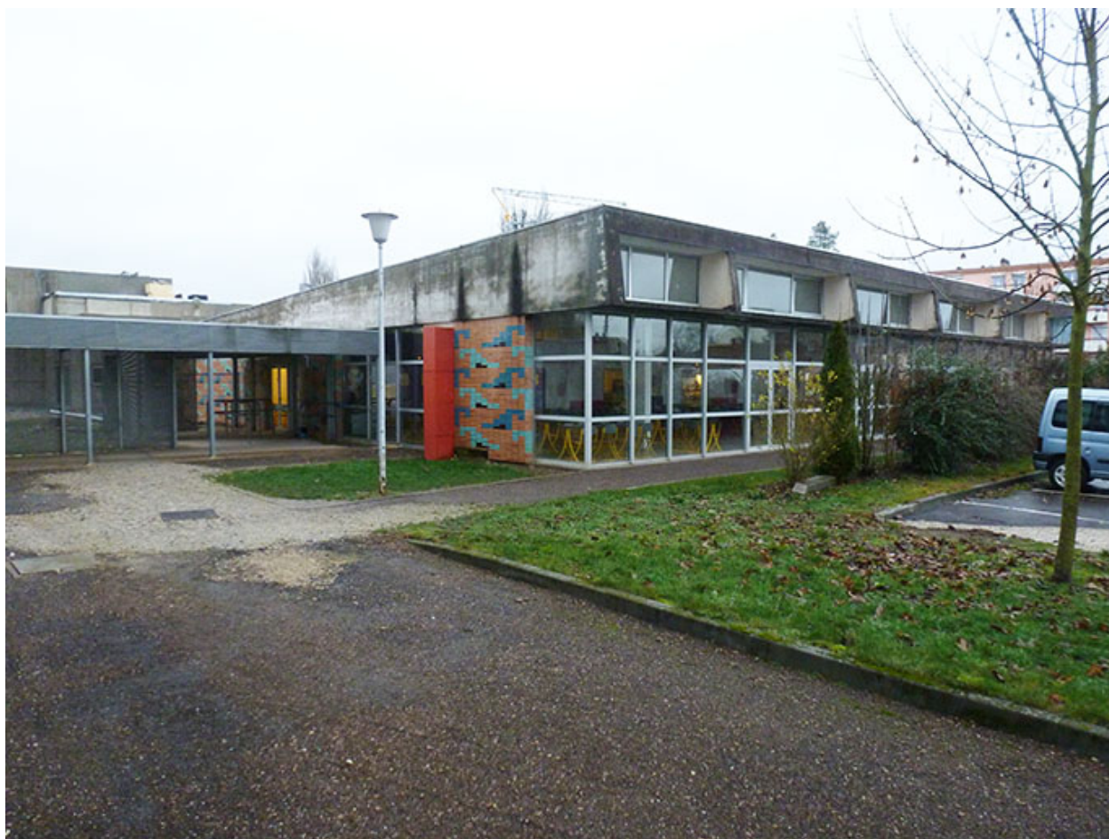
Angle sud-ouest de la cantine (en 2012)
