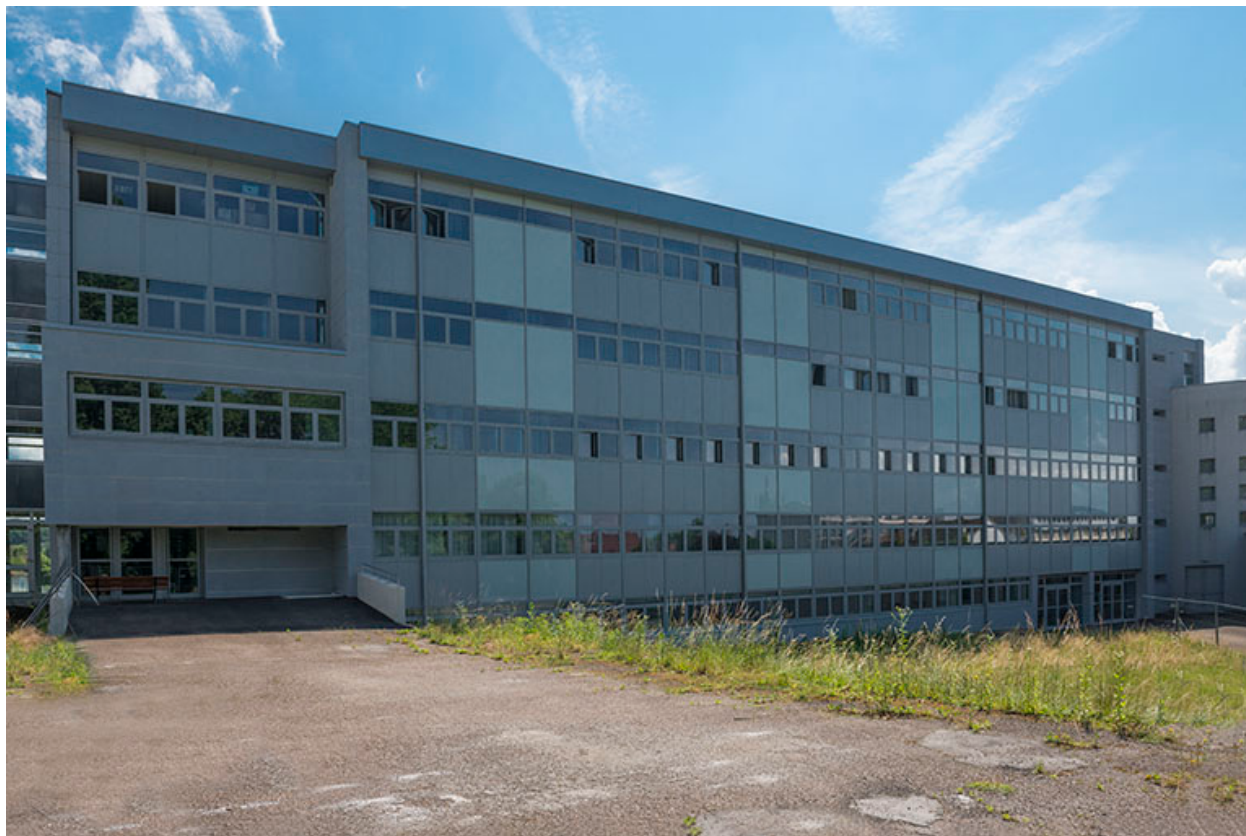
Façade ouest de l'externat.
