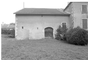
Façade de la ferme sur le parc. Phot. Jérôme Mongreville IVR43_19963901106X
