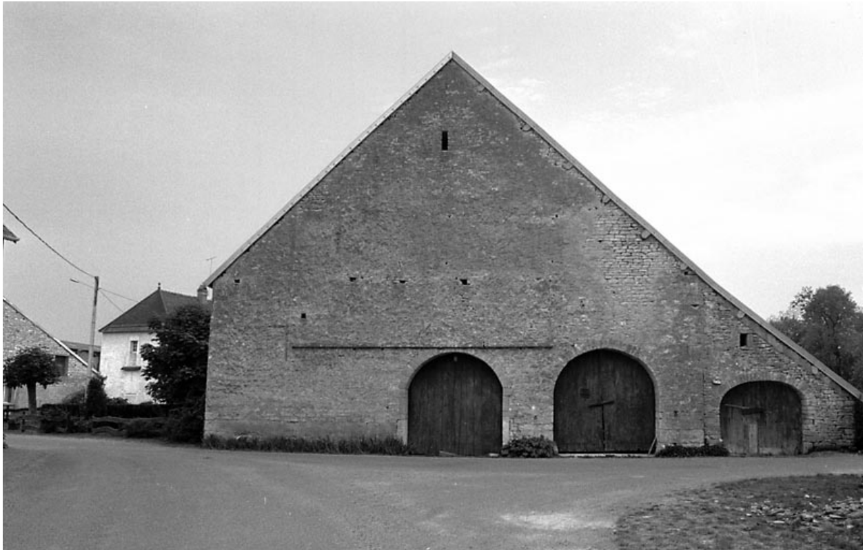
Façade latérale droite.
