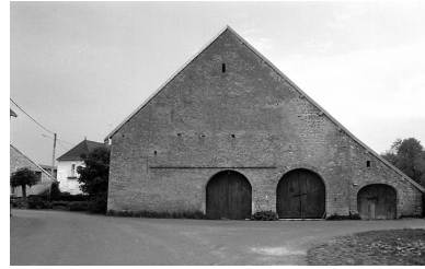
Façade latérale droite. Phot. Bernard Lardière IVR43_19797000056Z
