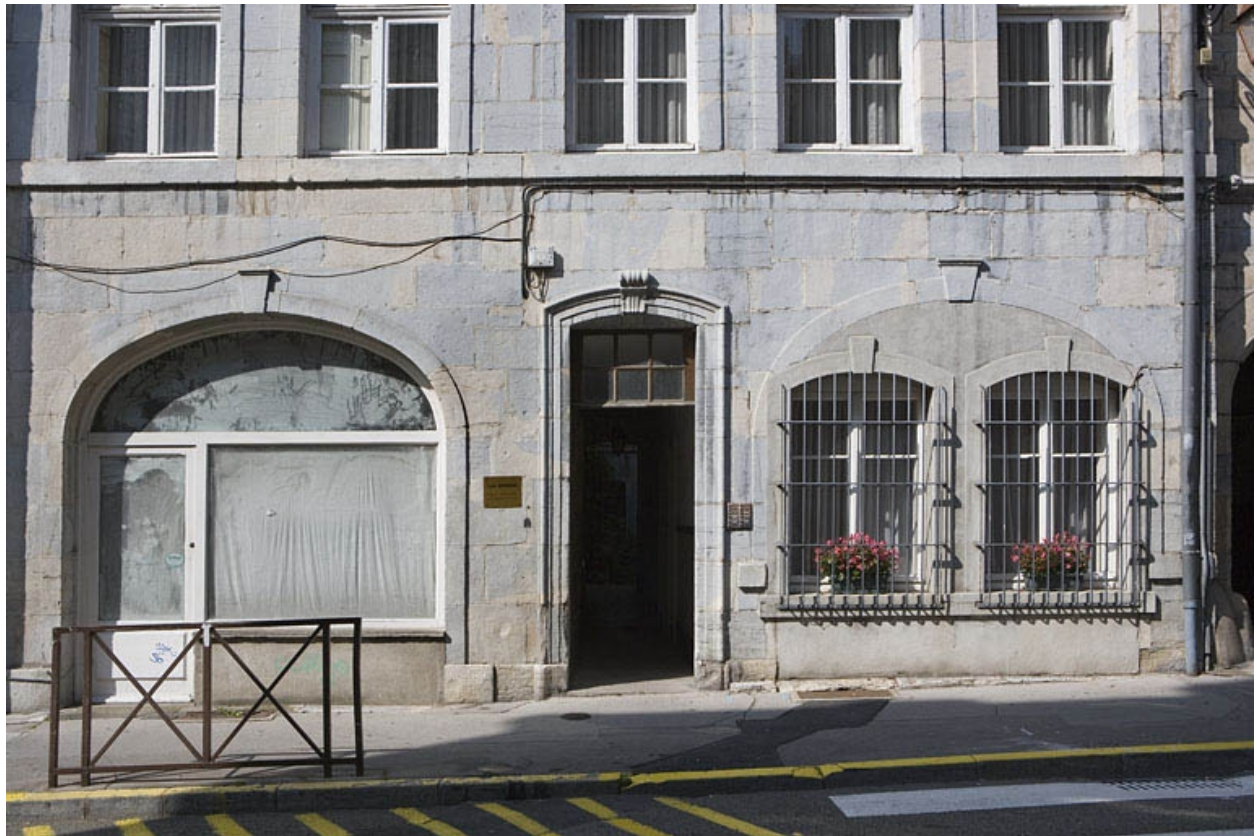
Logis sur rue, détail du rez-de-chaussée.
