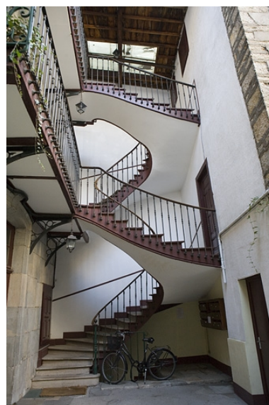
Détail de l'escalier à cage ouverte du logis principal. Phot. Yves Sancey IVR43_20092501378NUC2A
