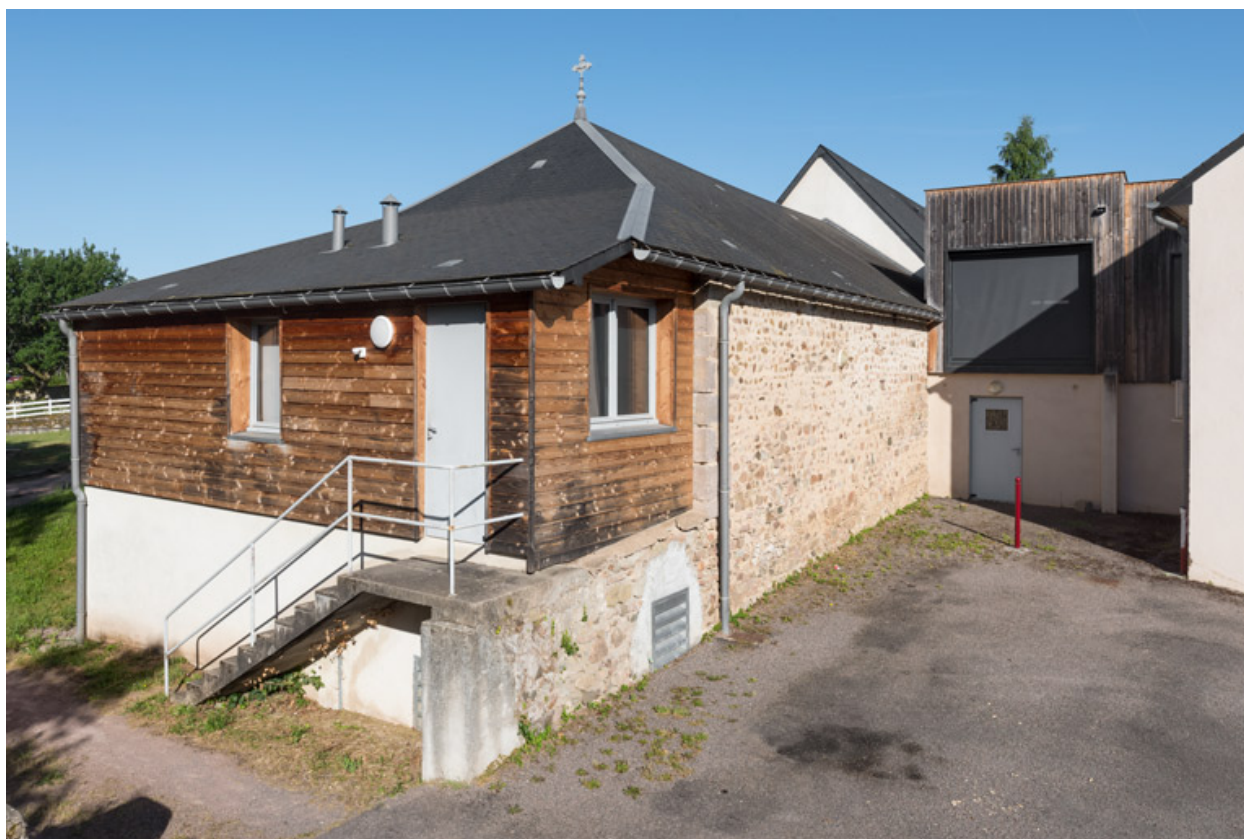
Façades postérieure et latérale gauche.
