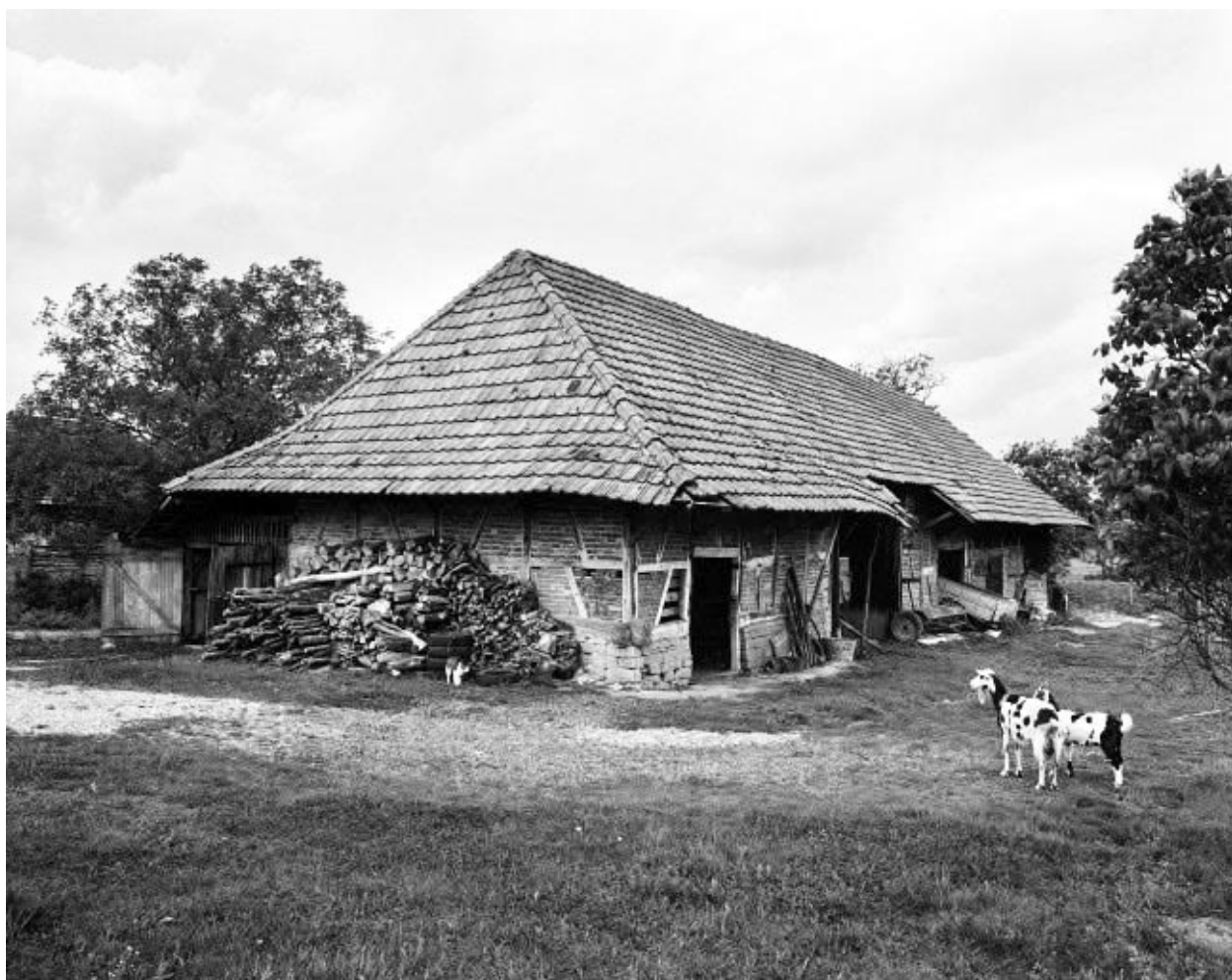
Ferme située rue du Cordeau : vue générale.
