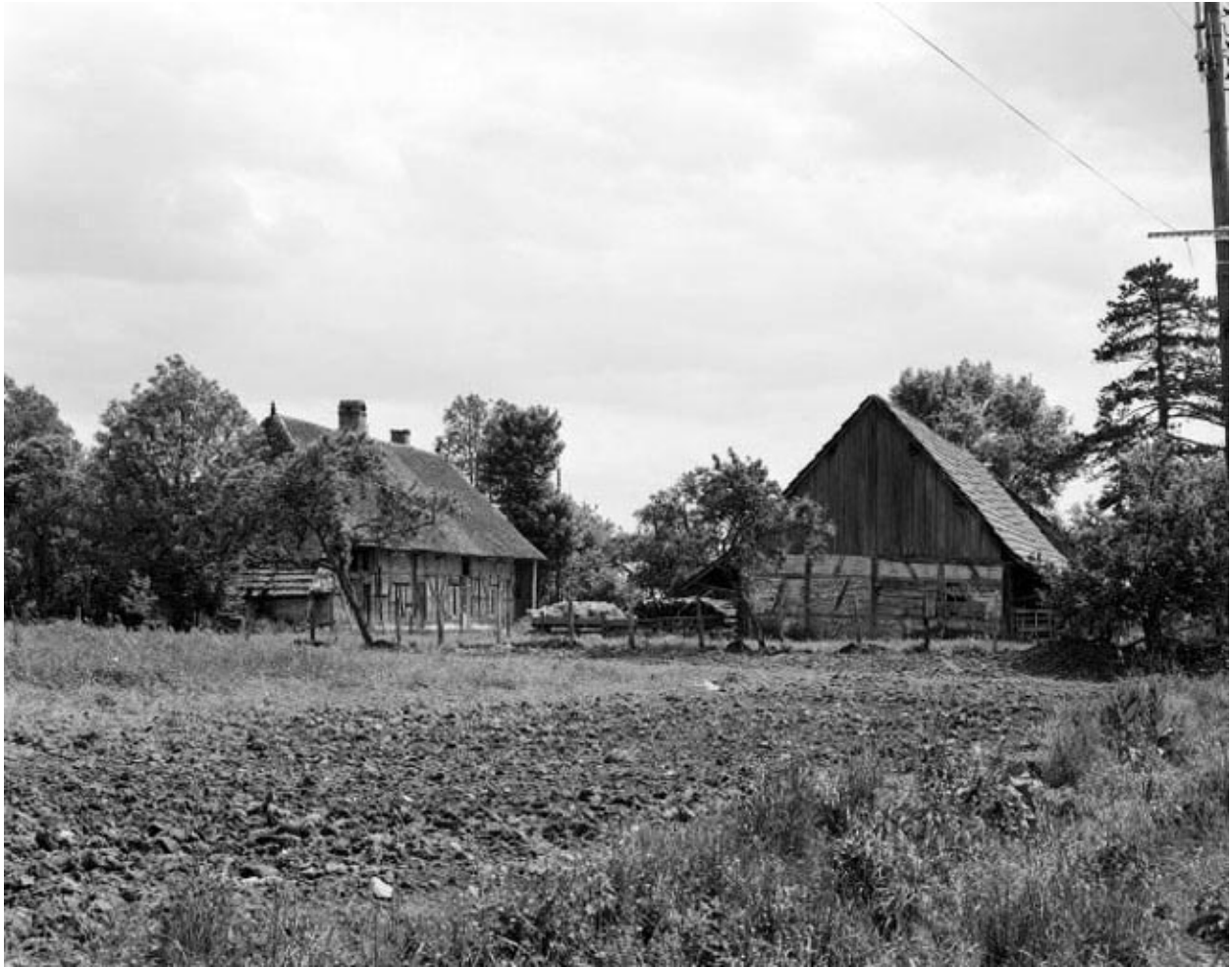
Ferme située 57 rue de Bourgogne : vue générale.
