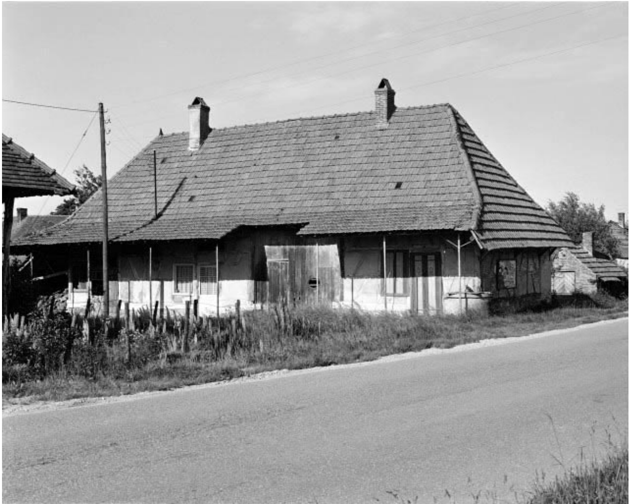
Ferme située 45 rue de Bourgogne : façades antérieure et latérale droite.
