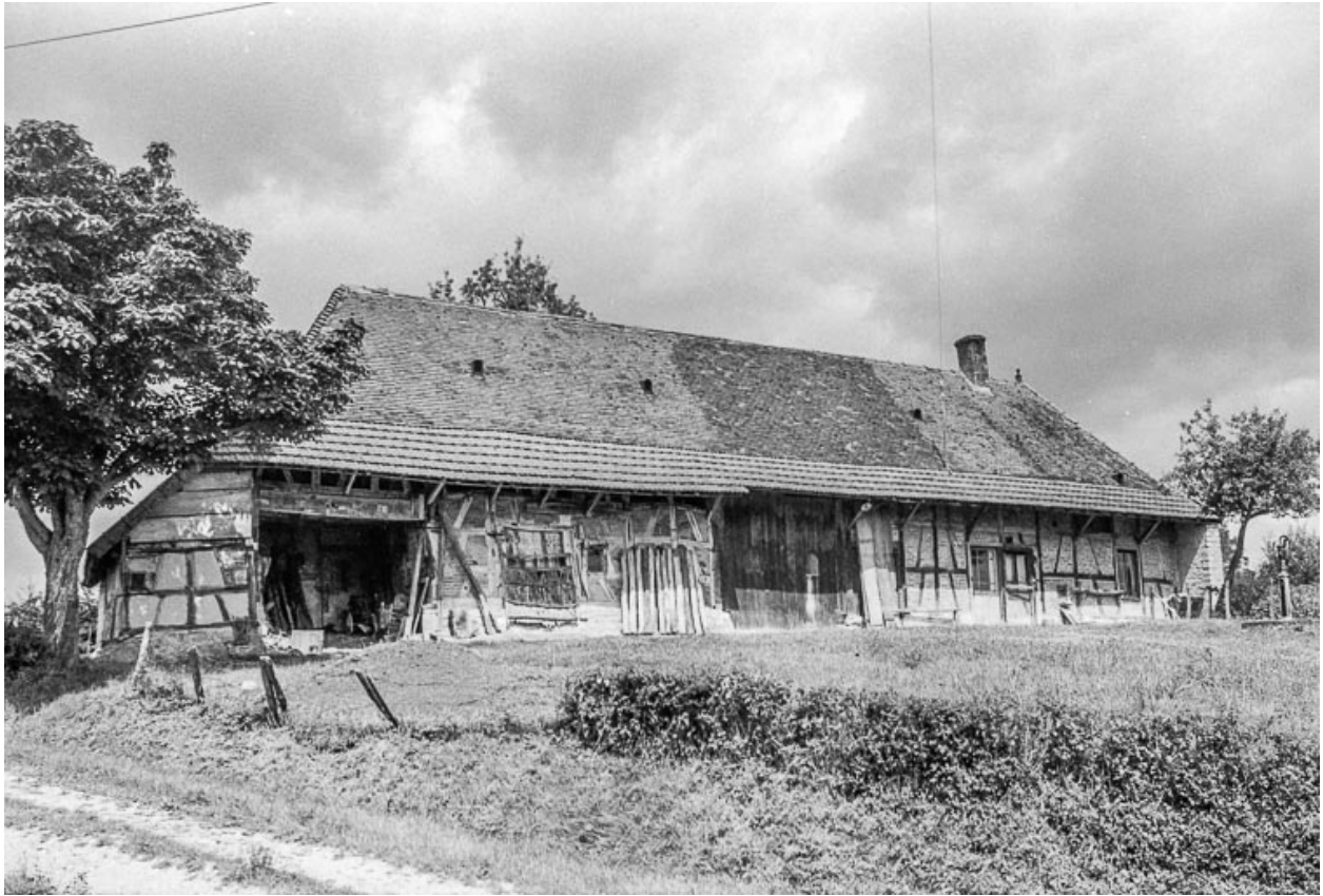
Ferme : vue générale.
