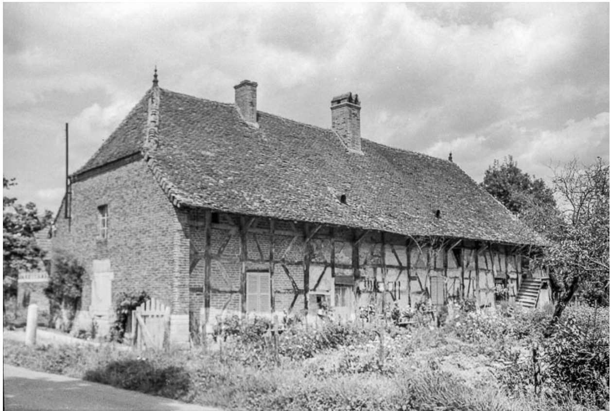
Ferme : vue générale.
