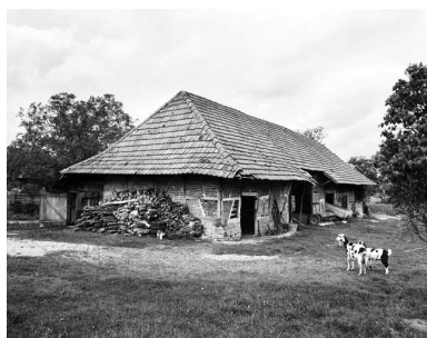
Ferme située rue du Cordeau : vue générale. Phot. Bernard Lardière IVR43_19793900358X
