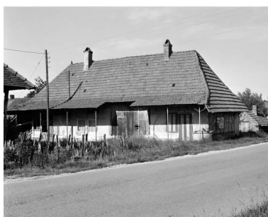
Ferme située 45 rue de Bourgogne : façades antérieure et latérale droite. Phot. Bernard Lardière IVR43_19793900361X
