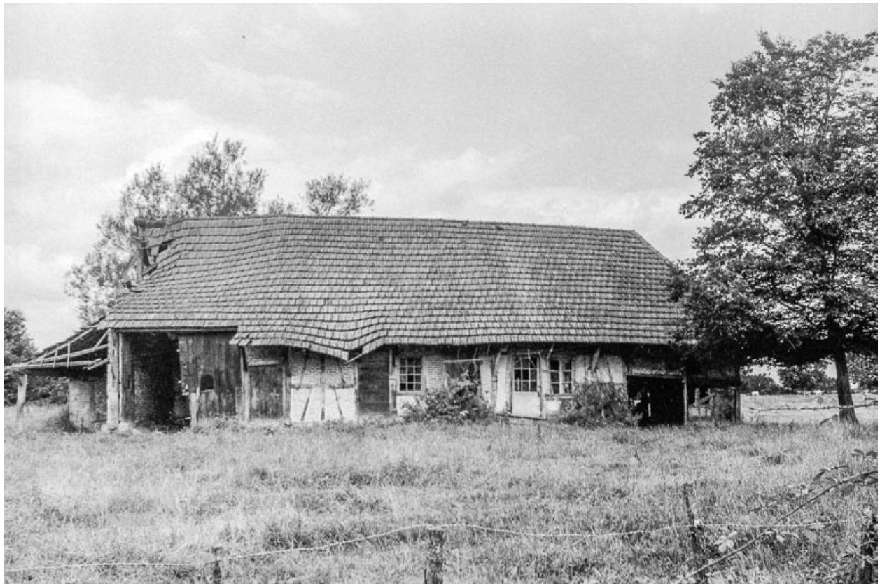
Ferme : vue générale.
