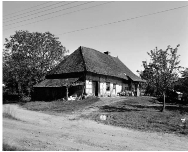
Ferme située rue du Moulin de Jousseau : façades antérieure et latérale gauche. Phot. Bernard Lardière IVR43_19793900362X
