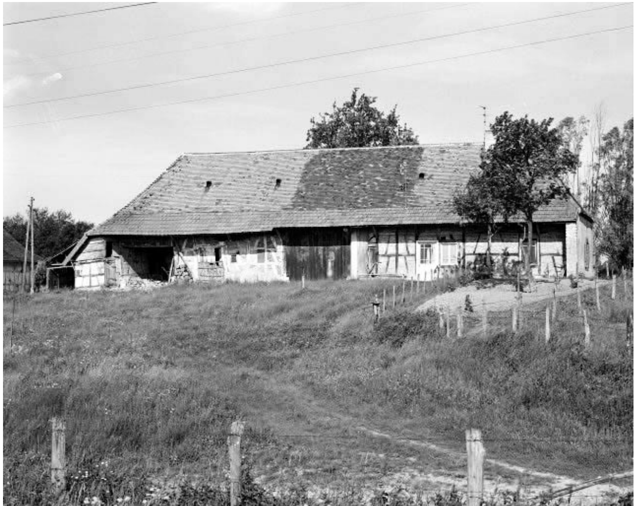
Ferme située rue des Prés de Sottessard : façade antérieure.
