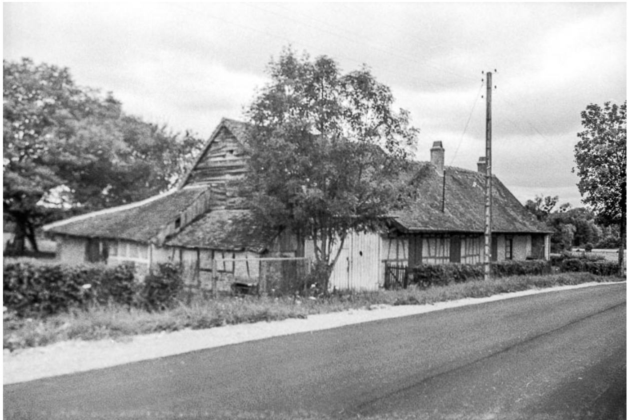
Ferme : vue générale.
