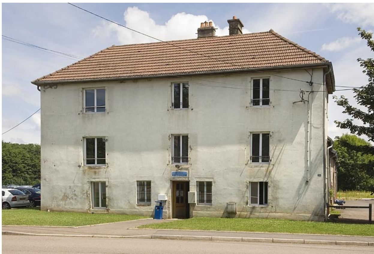
Bâtiment des commis. Façade ouest.
