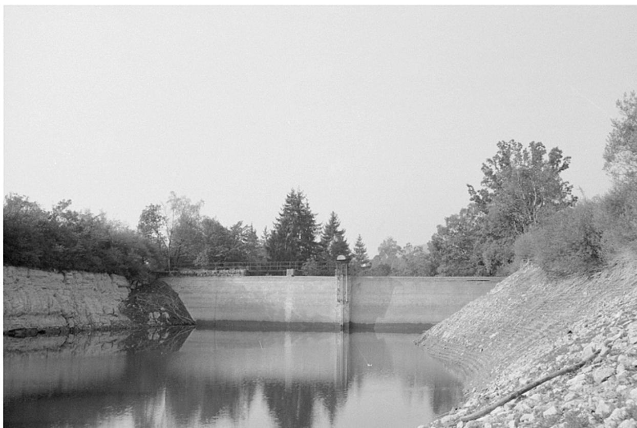
Barrage et bassin de retenue.
