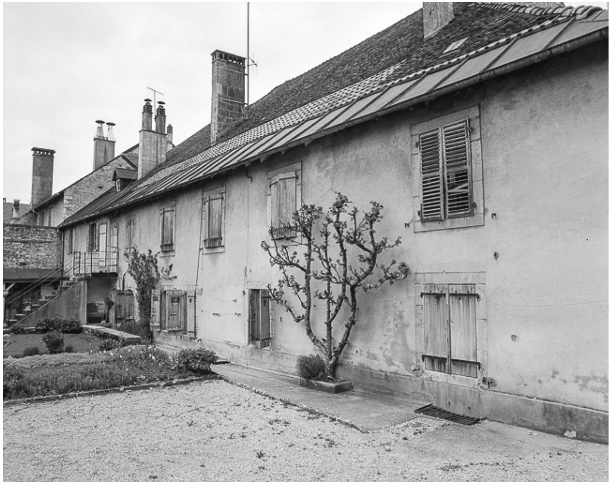
Façade postérieure (habitation).
