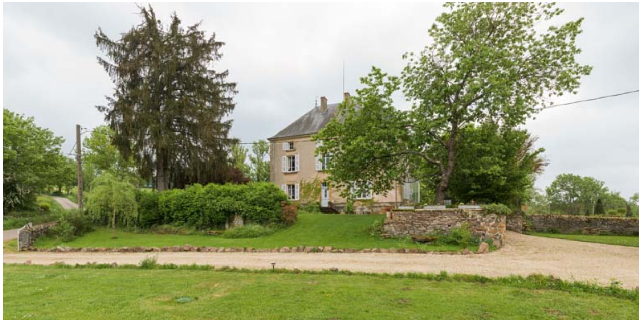
Maison d'habitation. Vue d'ensemble depuis le nord.
