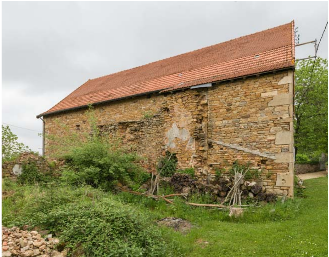
Façade postérieure de l'étable.
