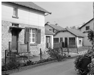
Maison identique, 26, 28 rue de Lorraine, la remise.
