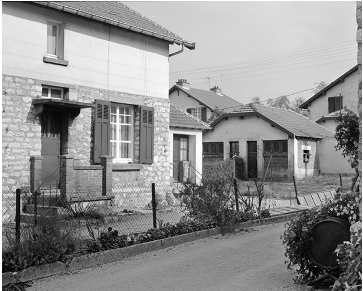
Maison identique, 26, 28 rue de Lorraine, la remise.
