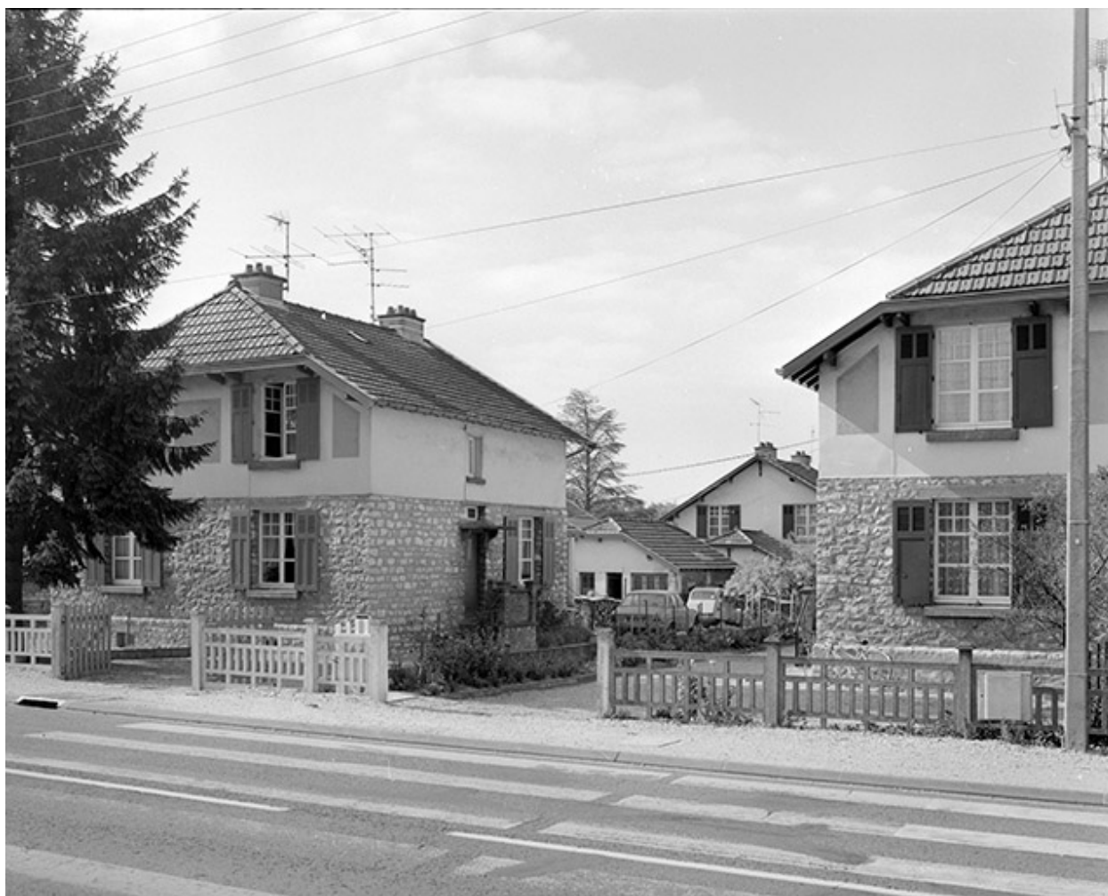
Maison identique, 40, 42 rue de Belvove, façade antérieure et face droite.
