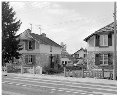
Maison identique, 40, 42 rue de Belvoye, façade antérieure et face droite.
