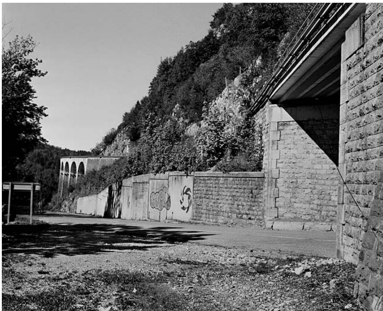
Elévation sud, de profil.
