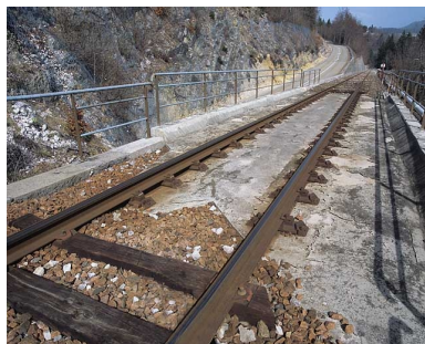
Système d'attaches directes sur le tablier. Phot. Yves Sancey IVR43_20053900356XA
