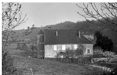
Vue générale. Phot. Guy Forestier IVR43_19743900298Z
