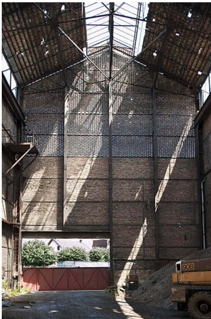
Bâtiment du gazogène. Vue intérieure depuis l'ouest.
