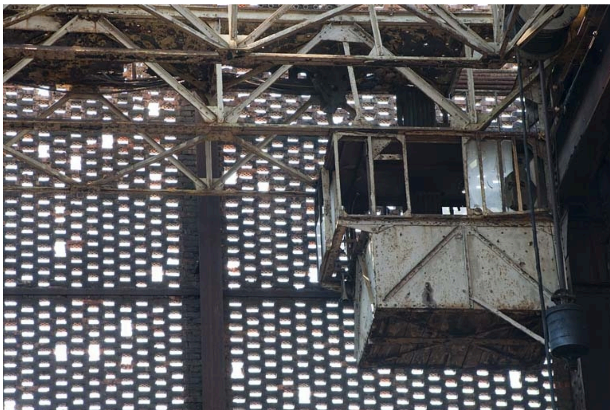
Bâtiment du gazogène. Cabine du pont roulant.
