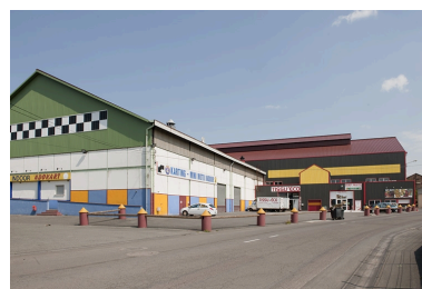
Ateliers de cisailage et de laminage (tôlerie n°4). Phot. Jérôme Mongreville IVR43_20122501287NUC4A
