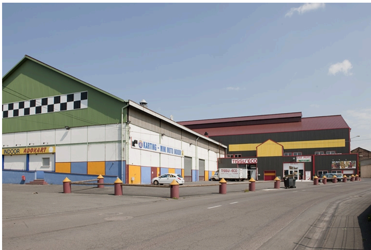
Ateliers de cisailage et de laminage (tôlerie n°4).
