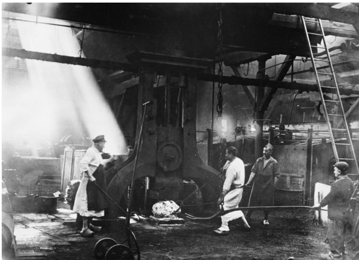
Le cinglage de la dernière loupe de fonte au bois. Photogr., s.n., s.d. [1904 ?].
