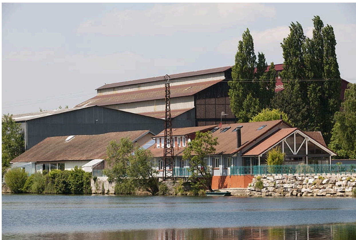
Bâtiments de l'aciérie depuis le sud-est.
