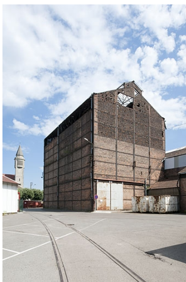
Bâtiment du gazogène. Vue depuis le nord-ouest. Phot. Jérôme Mongreville IVR43_20122501306NUC4A
