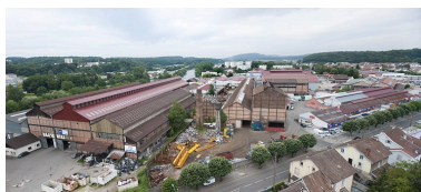
Vue plongeante panoramique depuis l'est.
