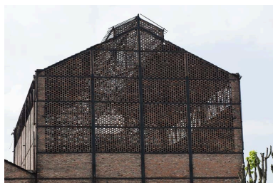
Partie supérieure du bâtiment du gazogène. Phot. Jérôme Mongreville IVR43_20122501291NUC4A
