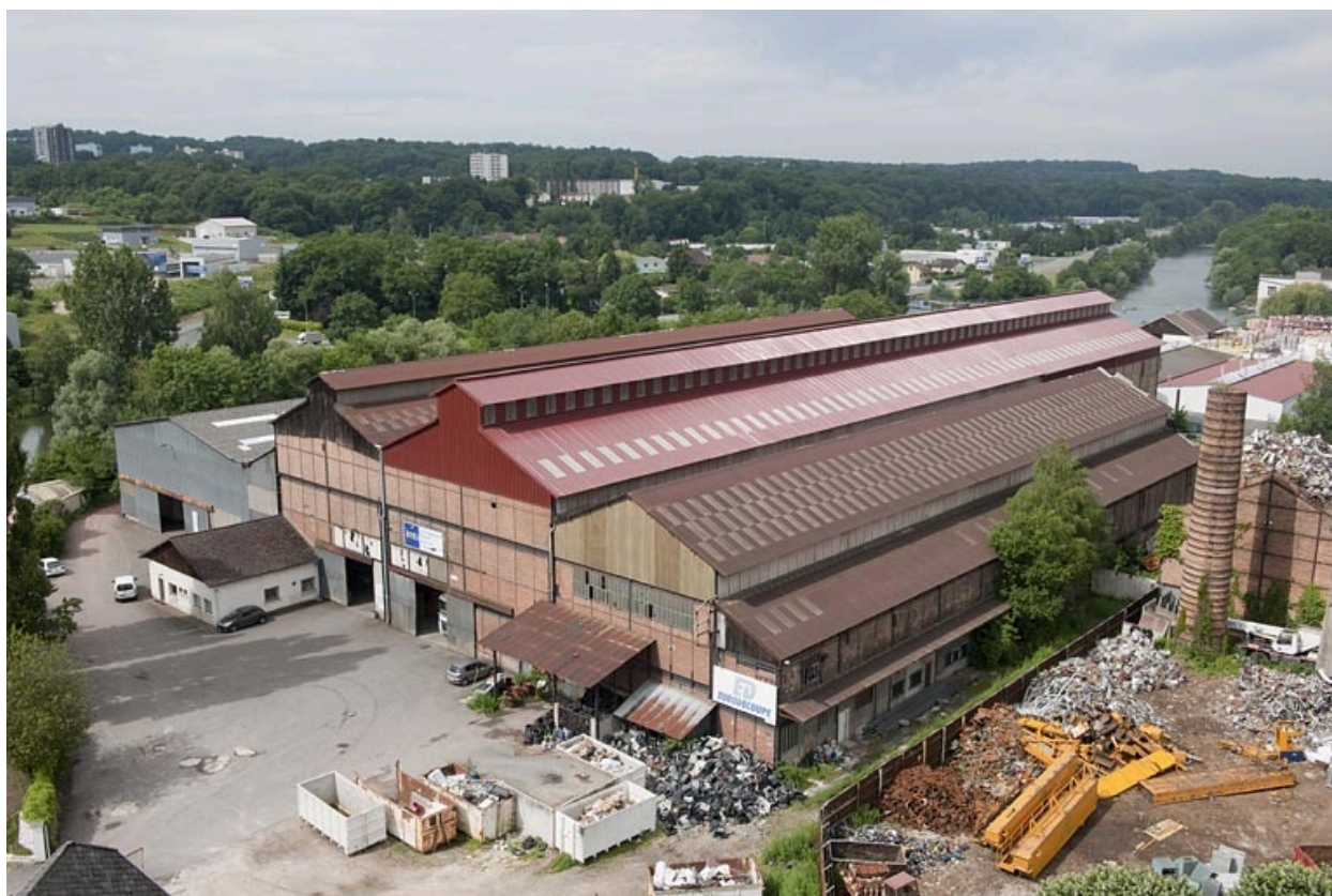
Vue plongeante sur les bâtiments de l'aciérie.
