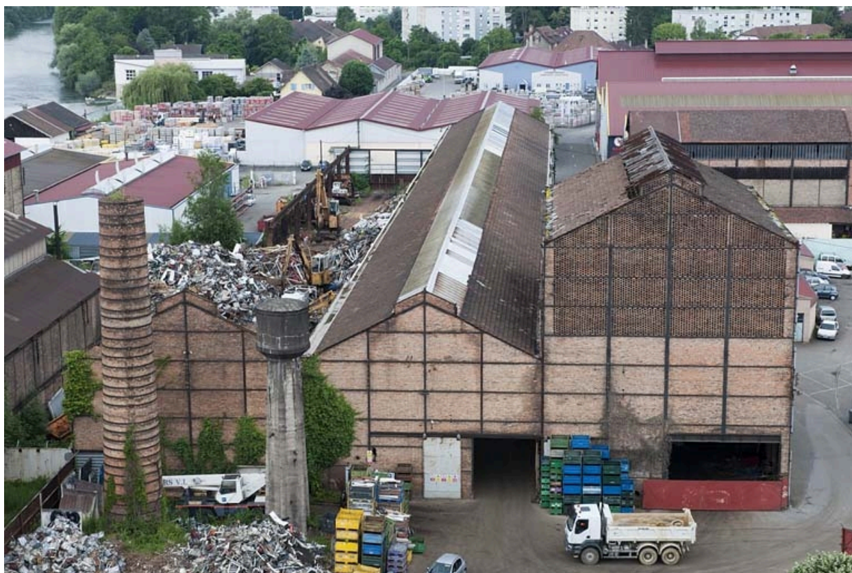
Vue plongeante sur l'atelier de laminage.
