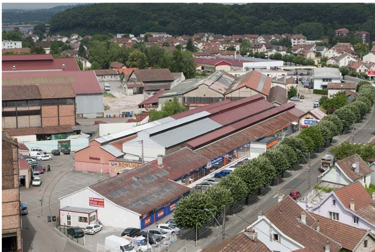
Vue plongeante sur les bâtiments (division Chauffage et Chaudronnerie) et les ateliers de mécanique.
