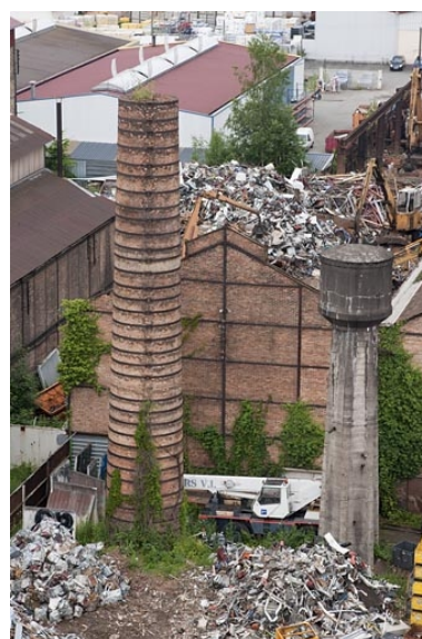
Cheminée et château d'eau.
