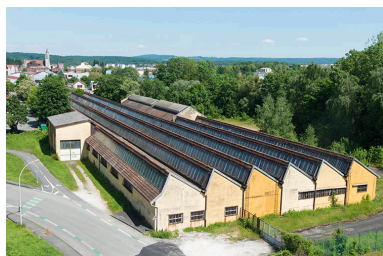
Vue plongeante sur l'ancien atelier de tréfilerie.
