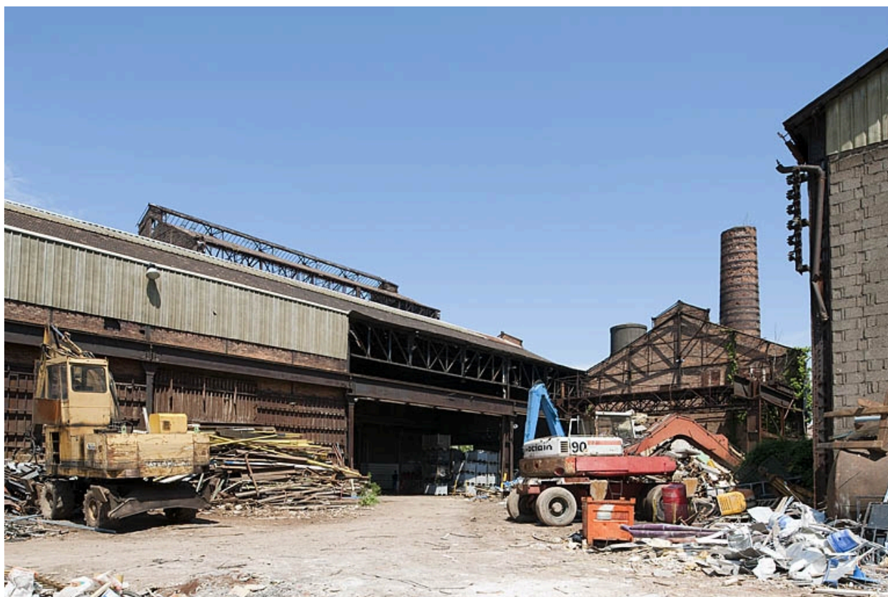
Travées de l'atelier de laminage.
