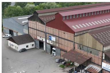
Pignons est des bâtiments de l'aciérie. Phot. Jérôme Mongreville IVR43_20122501282NUC4A
