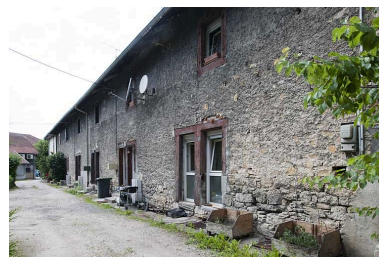
Cité ouvrière dite "du Magasin". Façade sud. Phot. Jérôme Mongreville IVR43_20122501310NUC4A
