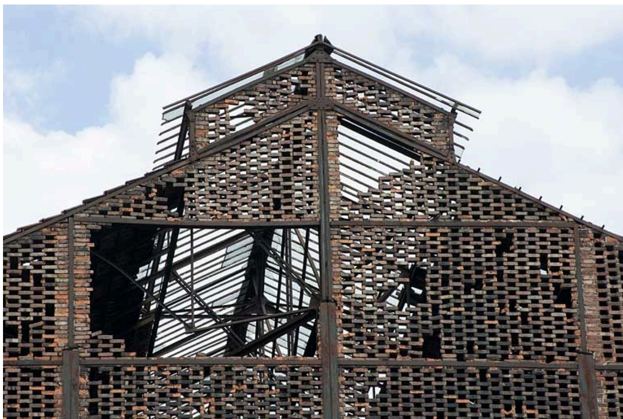
Bâtiment du gazogène. Pignon ouest.
