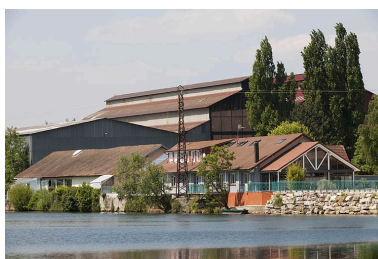
Bâtiments de l'aciérie depuis le sud-est.
