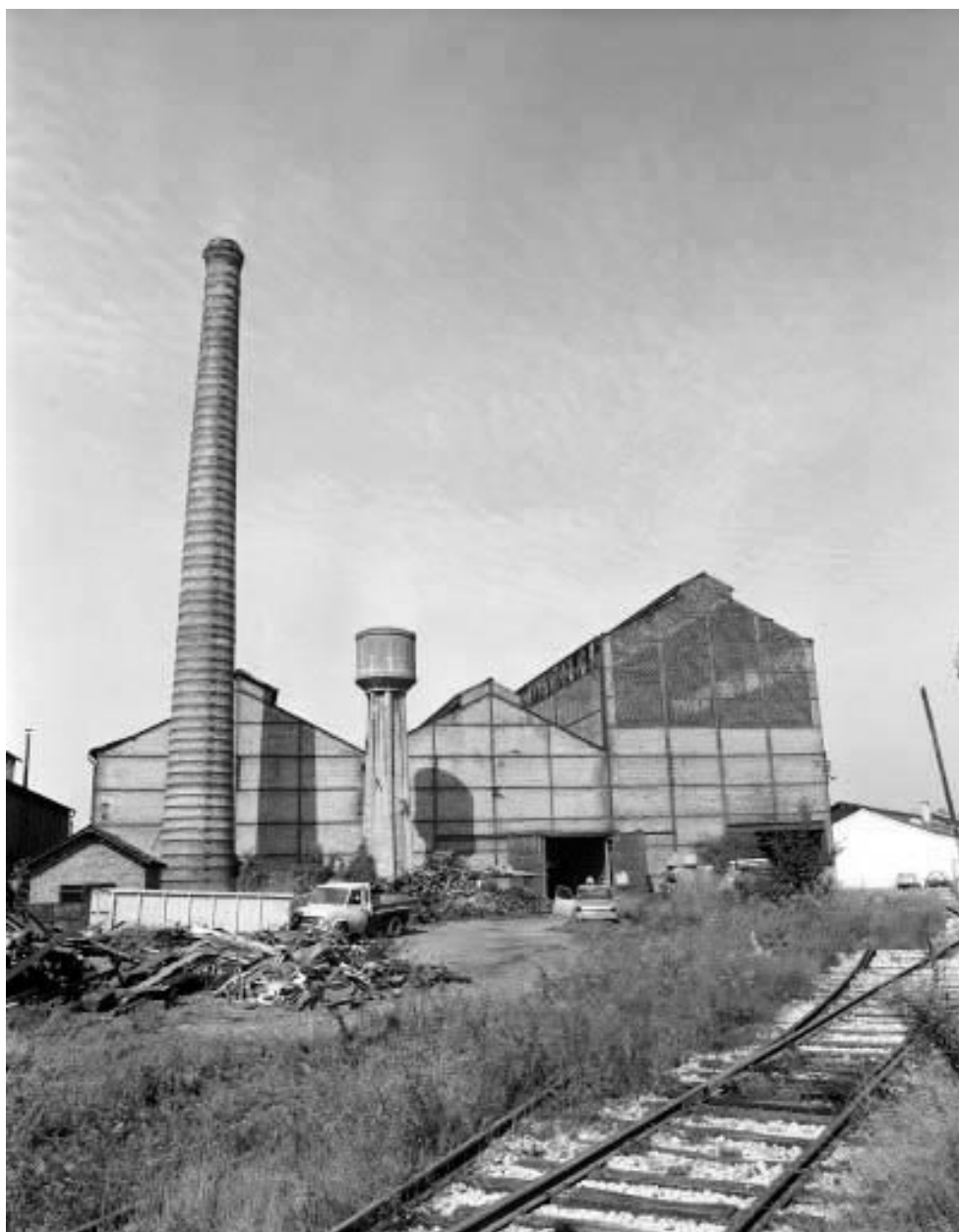
Atelier de laminage et bâtiments des fours en 1981.
