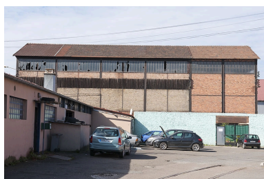
Façade est de l'atelier de laminage (tôlerie n°4). Phot. Jérôme Mongreville IVR43_20122501764NUC4A
