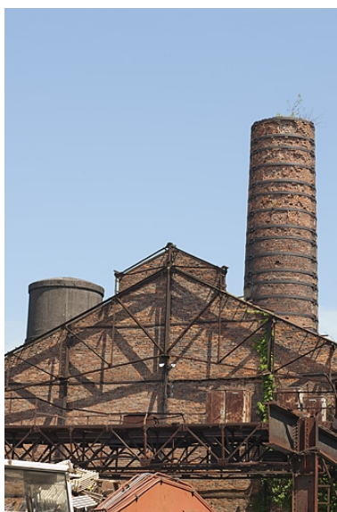
Pignon est d'un atelier de laminage.
