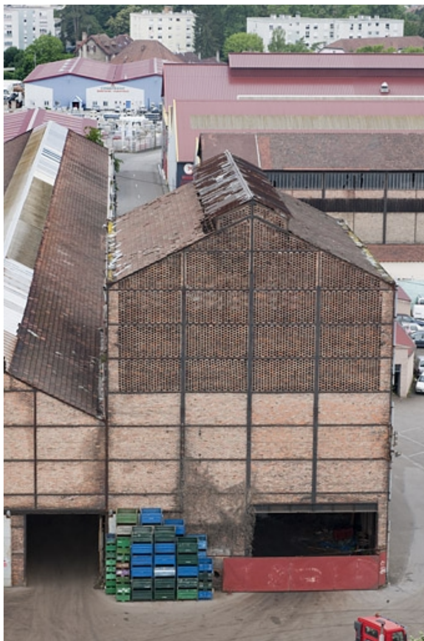
Vue plongeante sur le bâtiment du gazogène.
