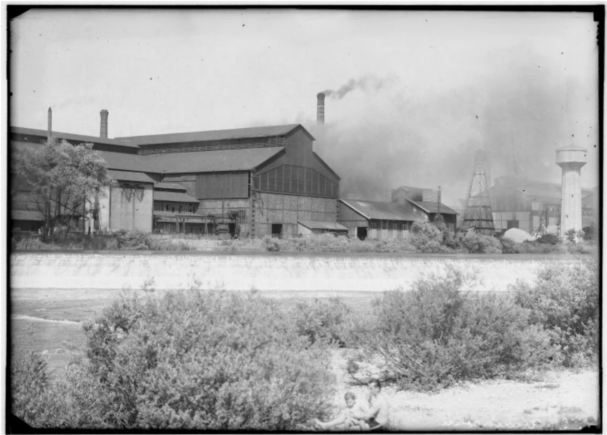
Atelier de laminage [1re moitié 20e siècle].
