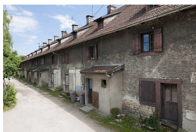
Cité ouvrière dite "du Magasin". Façade nord. Phot. Jérôme Mongreville IVR43_20122501311NUC4A
