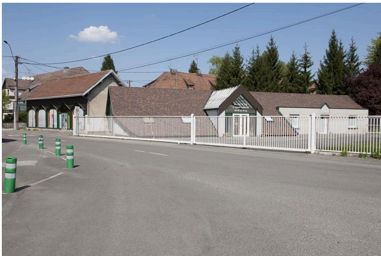
Remise à matériel d'incendie, pesage et bureau de paye.
