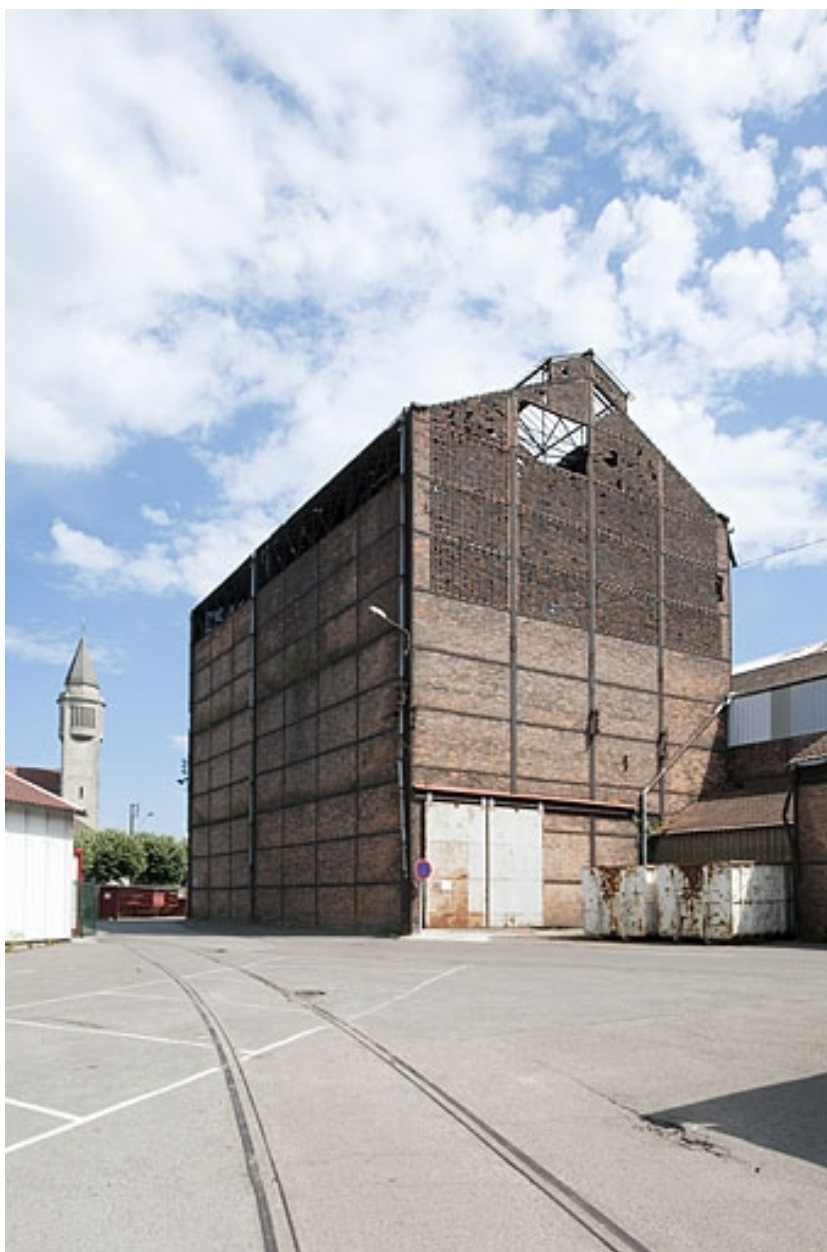
Bâtiment du gazogène. Vue depuis le nord-ouest.
