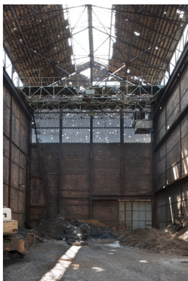
Bâtiment du gazogène. Vue intérieure depuis l'est. Phot. Jérôme Mongreville IVR43_20122501300NUC4A
