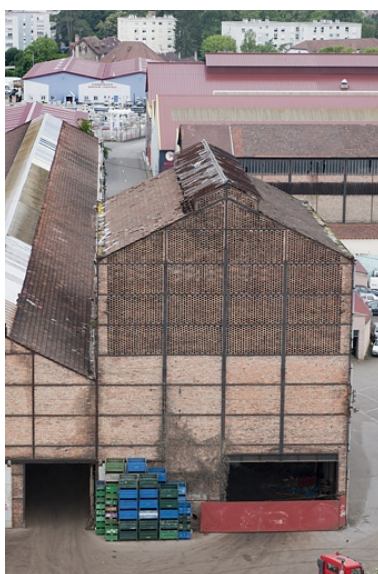
Vue plongeante sur le bâtiment du gazogène.
