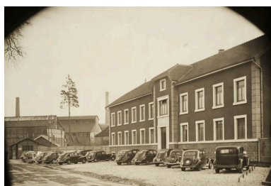
Bâtiment administratif. Photogr., s.n., s.d. [milieu 20e siècle]. Phot. Jérôme Mongreville IVR43_20112500289NUC4A
