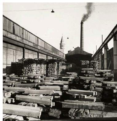
Le parc des gueuses de fonte. Photogr., s.n., s.d. [milieu 20e siècle]. Phot. Jérôme Mongreville IVR43_20112500301NUC4A
