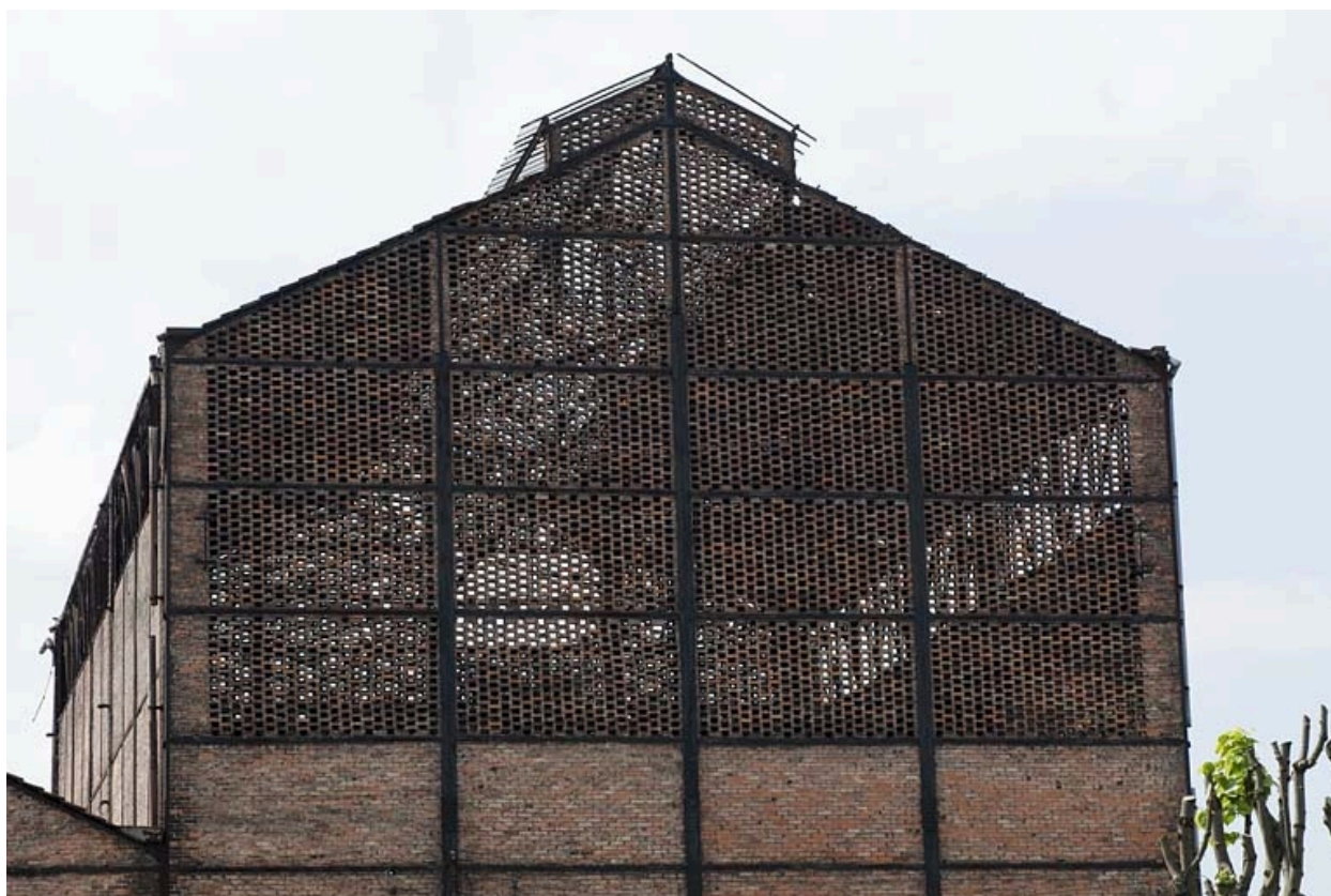
Partie supérieure du bâtiment du gazogène.
