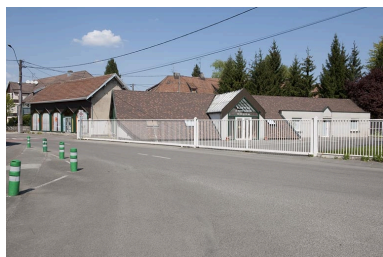
Remise à matériel d'incendie, pesage et bureau de paye. Phot. Jérôme Mongreville IVR43_20122501285NUC4A
