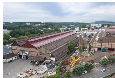
Vue plongeante sur la partie sud.
