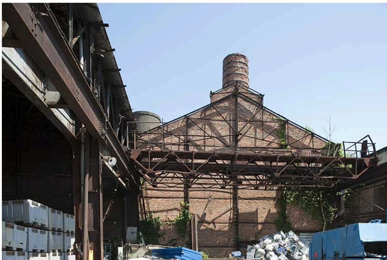
Atelier de laminage (partie découverte). Pignon est et vestiges du pont roulant.
