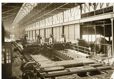
Le laminoir. Photogr., s.n., s.d. [milieu 20e siècle]. Phot. Jérôme Mongreville IVR43_20112500284NUC4A
