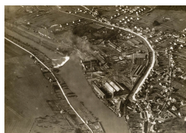
Vue aérienne des Forges depuis l'est. Photogr., s.n., s.d. [début 20e siècle].
