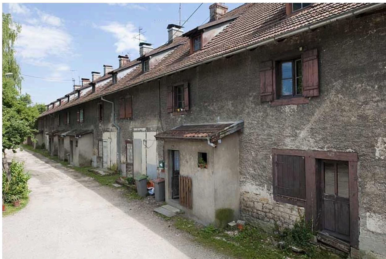
Cité ouvrière dite "du Magasin". Façade nord.
