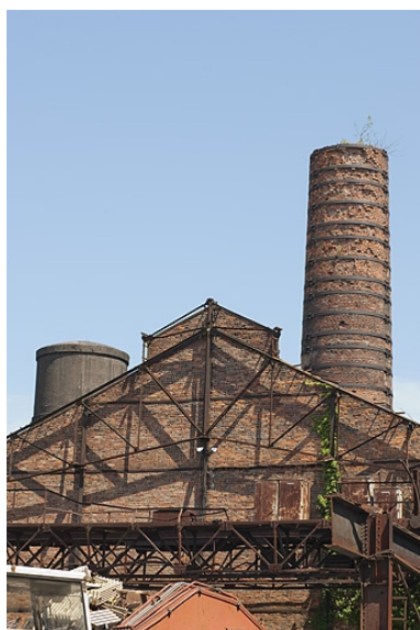
Pignon est d'un atelier de laminage.
