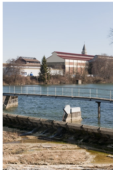
Vue d'ensemble des bâtiments est depuis le barrage.
