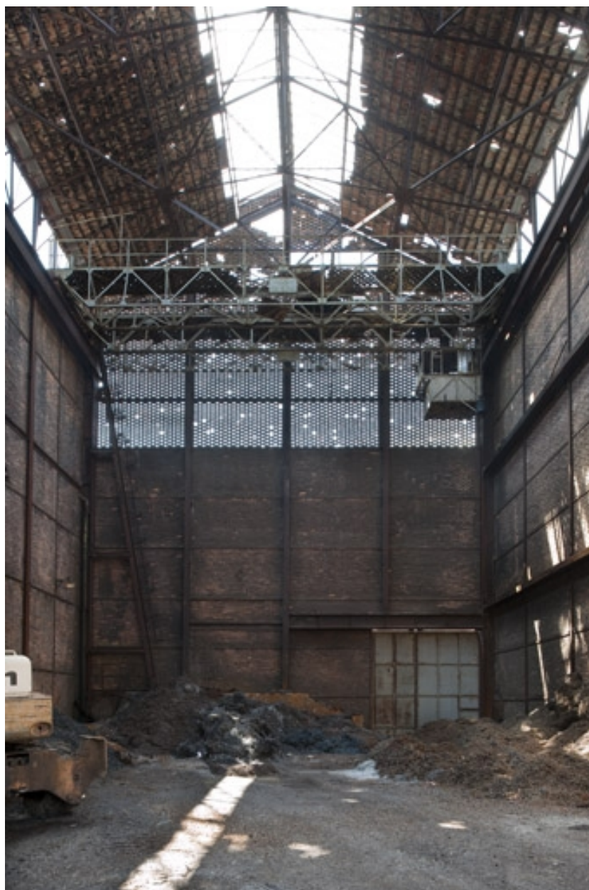
Bâtiment du gazogène. Vue intérieure depuis l'est.
