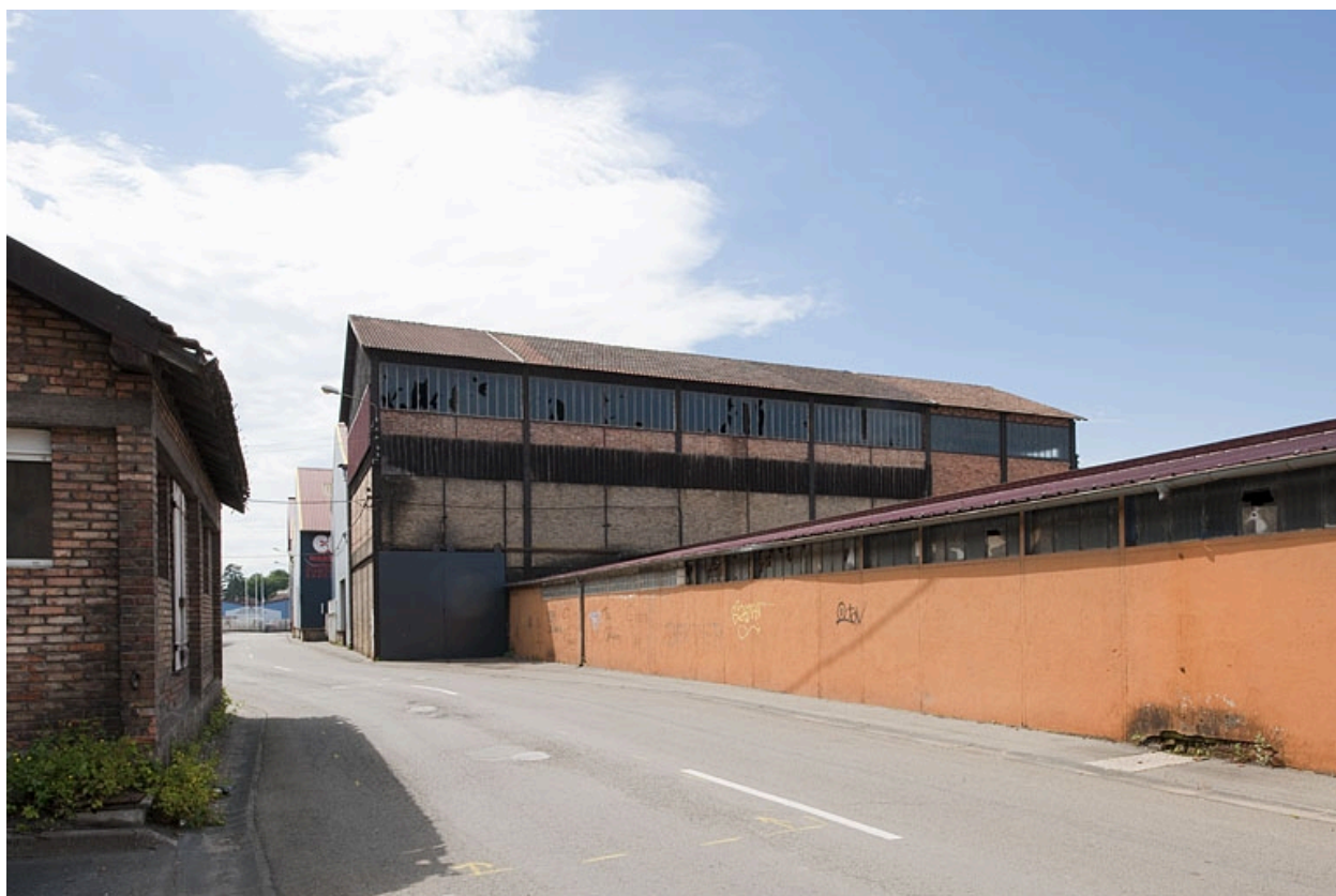
Atelier de laminage (tôlerie n°4) depuis le sud-est.
