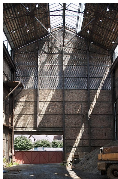
Bâtiment du gazogène. Vue intérieure depuis l'ouest. Phot. Jérôme Mongreville IVR43_20122501298NUC4A
