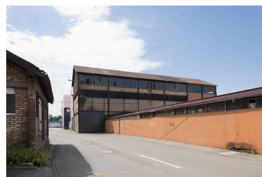
Atelier de laminage (tôle n°4) depuis le sud-est.
