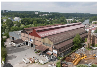
Vue plongeante sur les bâtiments de l'aciérie.
