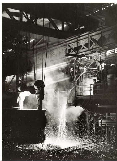
Coulée. Vue d'ensemble. Photogr., la Photothèque, Paris, s.n., s.d. [milieu 20e siècle]. Phot. Jérôme Mongreville IVR43_20112500295NUC4A
