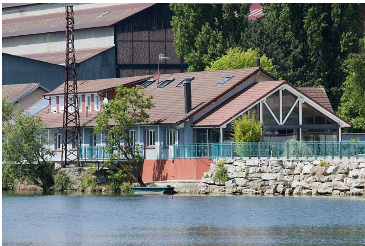
Magasins industriels (réhabilités) depuis le sud-est.
