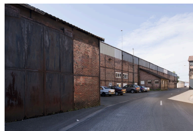
Façade nord de l'atelier de laminage. Phot. Jérôme Mongreville IVR43_20122501763NUC4A
