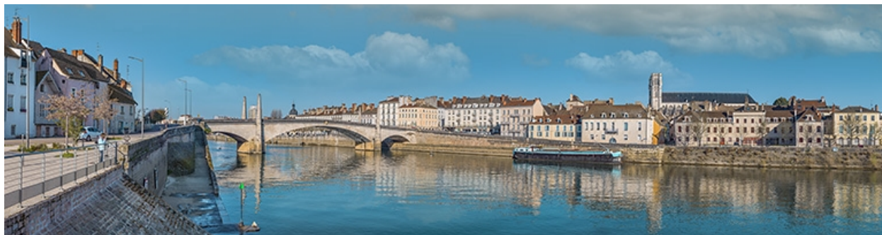
Vue d'ensemble depuis l'amont.
