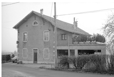
Façade antérieure. Phot. Laurent Poupard IVR43_19913901073Z
