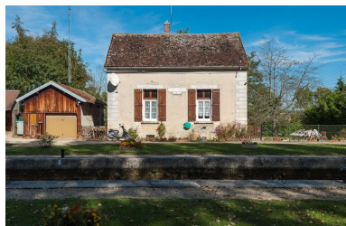
Maison éclusière de face avec son annexe.
