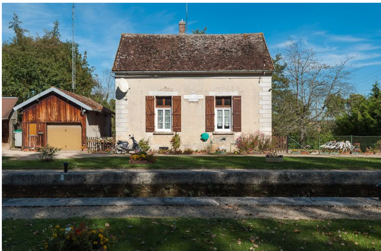
Maison éclusière de face avec son annexe.
