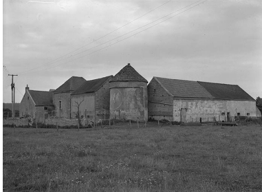
Vue d'ensemble de la ferme. Phot. Jean-Luc Duthu IVR26_19748901036X
