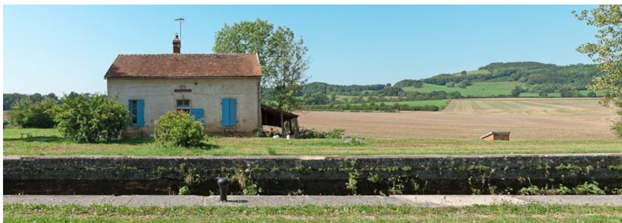
Vue de face de la maison éclusière.
