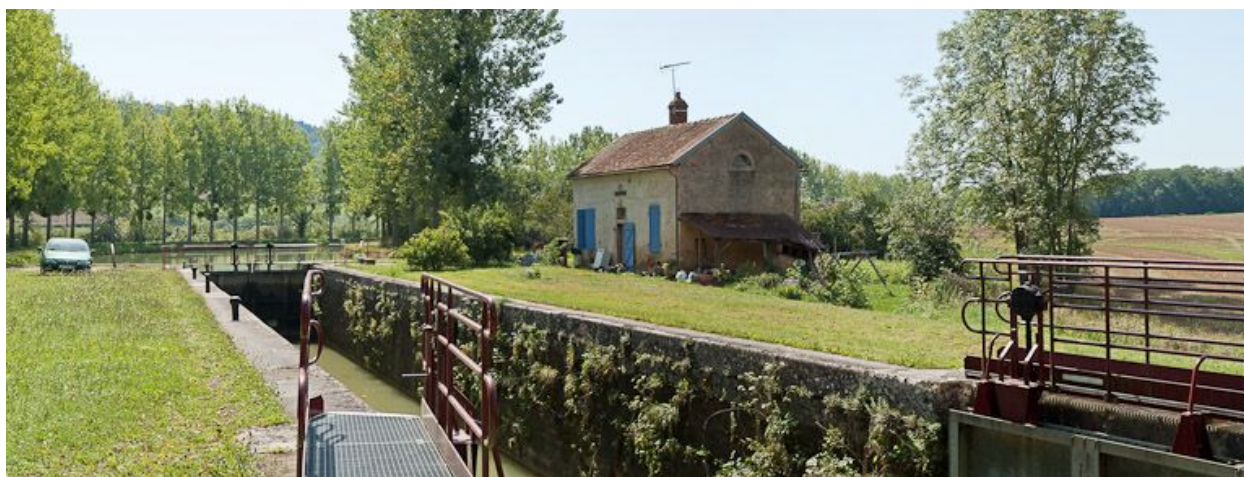
Vue d'ensemble du site d'écluse.
