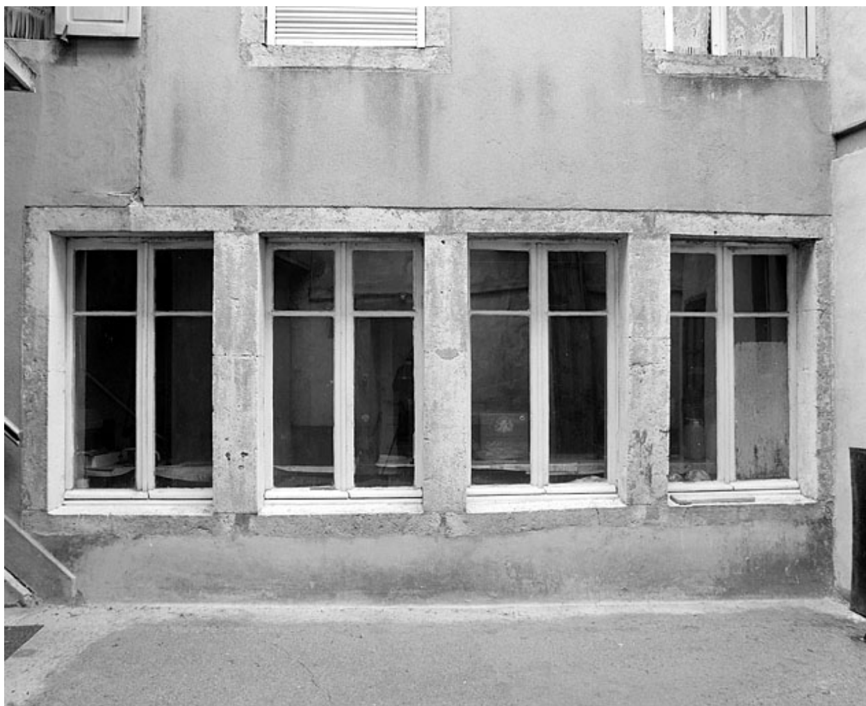
Aile sud : fenêtres jumelées.
