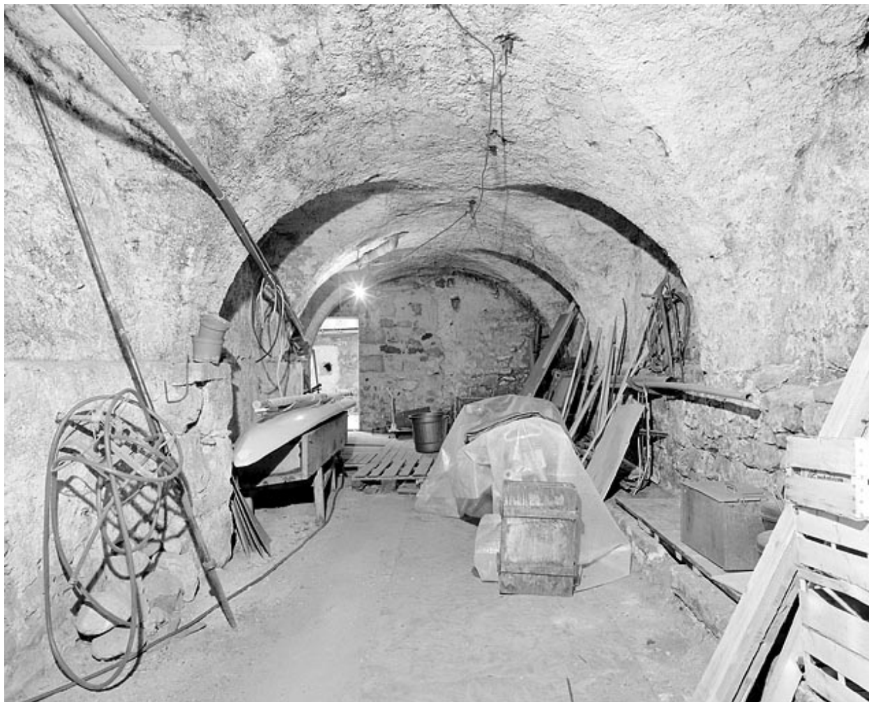
Aile est : rez-de-chaussée voûté.
