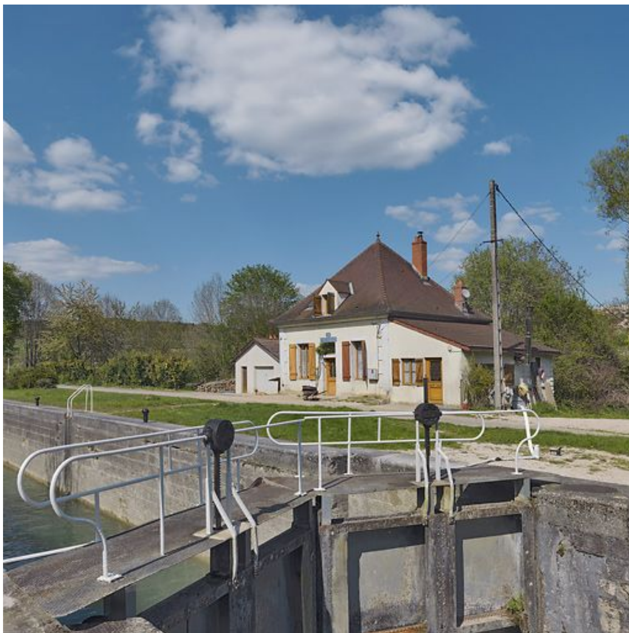
Maison éclusière vue d'aval.
