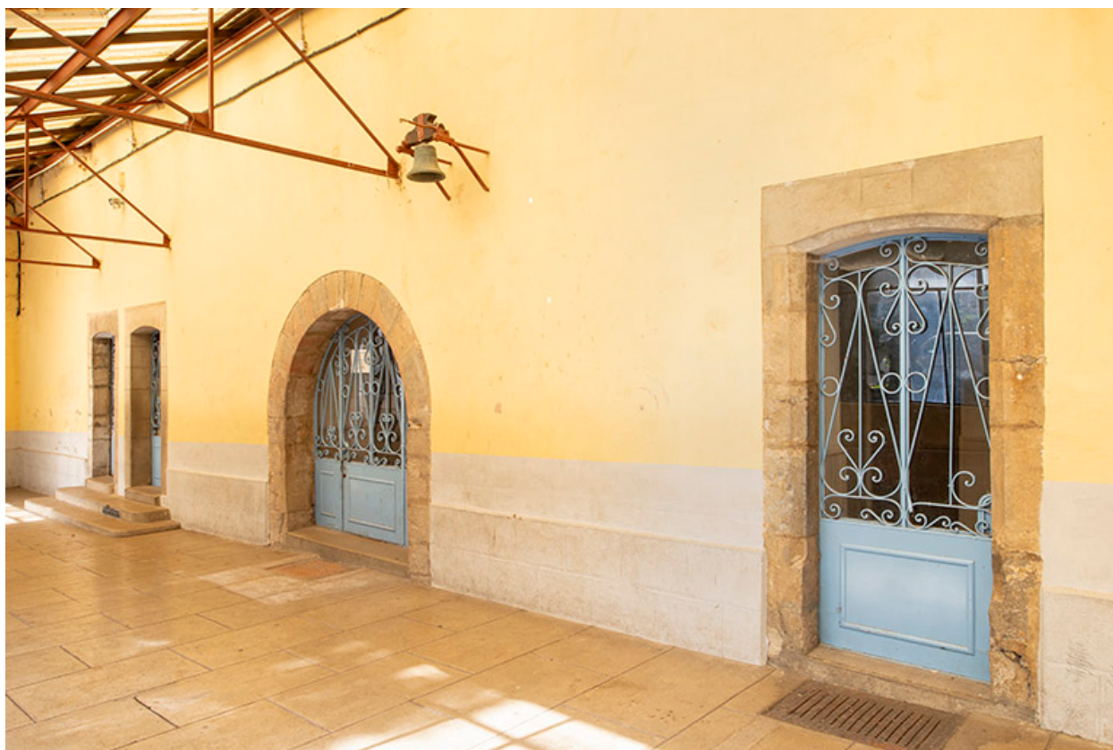
Bâtiment conventuel. Ouvertures de la façade est.
