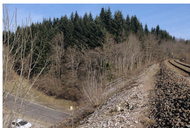
Plate-forme, depuis la voie côté La Cluse. Phot. Yves Sancey IVR43_20053900033ZA
