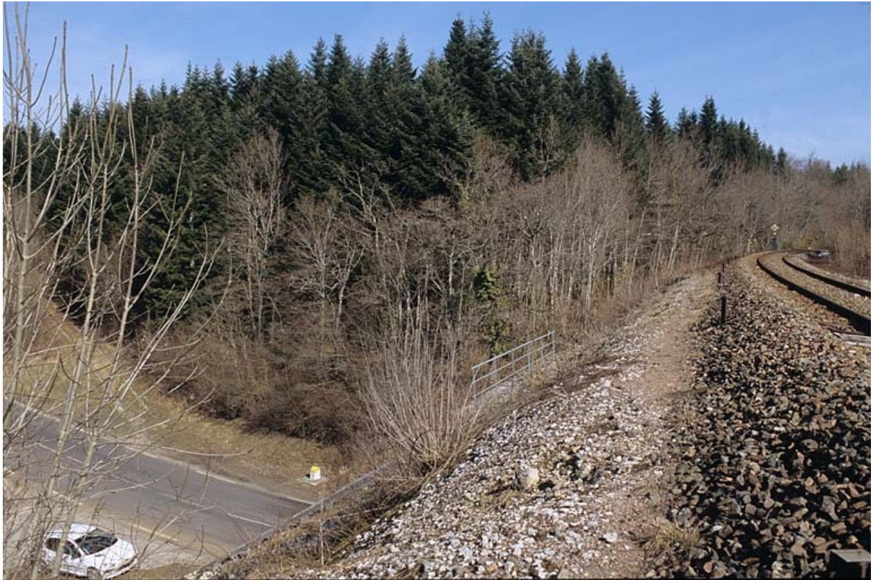
Plate-forme, depuis la voie côté La Cluse.
