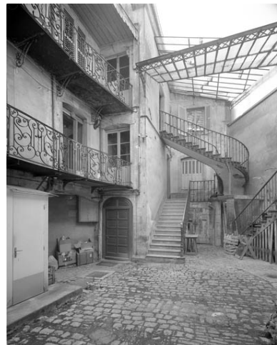
Façade postérieure sur cour.
