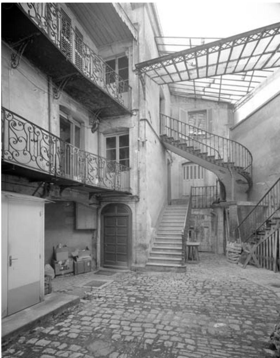
Façade postérieure sur cour.
