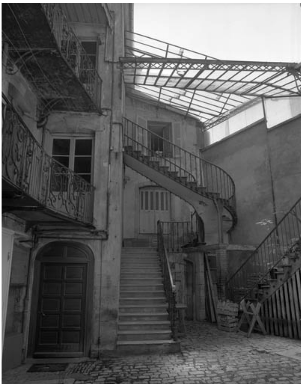
Détail de l'escalier de distribution extérieure.
